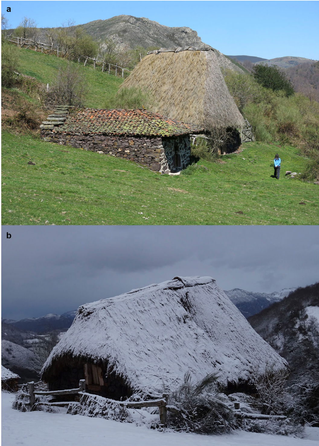
Figure 2. Broom thatching: a) Braña del Rebellón and b) Braña de Tuiza (Teverga, Asturias).
