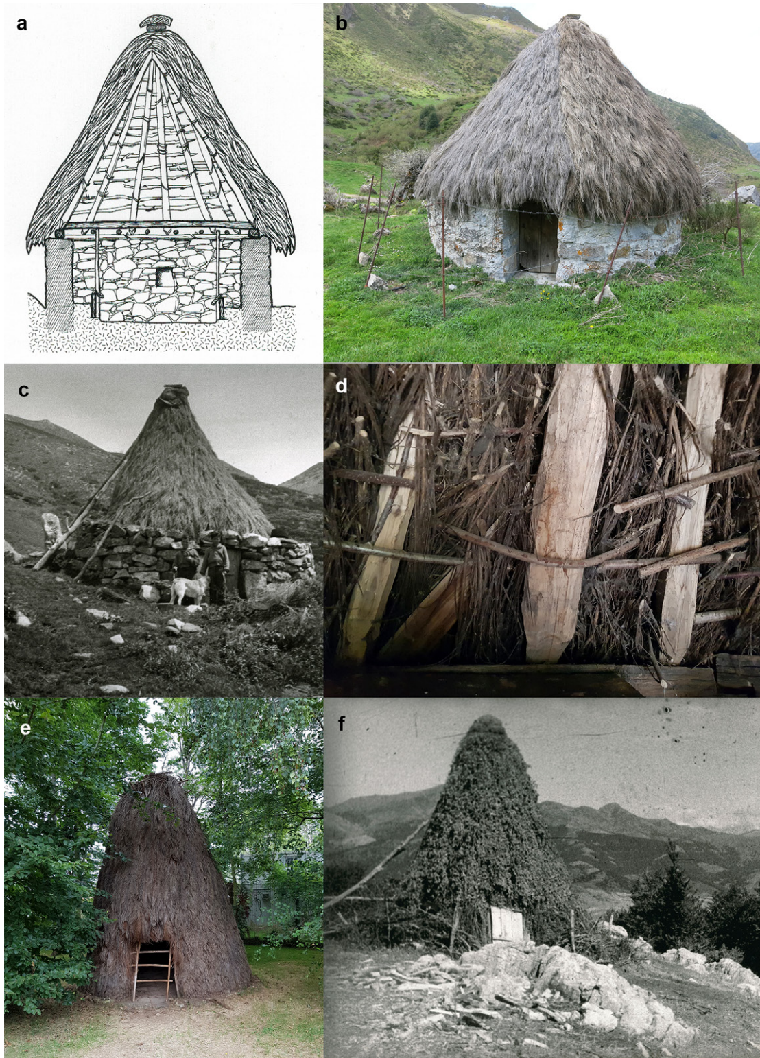
Figure 3. Small huts thatched with broom ( chozos ): a) diagram of a chozo de horma (Graña and López Álvarez 2007: 146), b) chozo de horma in Brañaviecha (Somiedo, Asturias), c) chozo of La Fonfría (León, photograph by José Ramón Lueje, 1936, courtesy of Museo del Pueblo de Asturias), d) interior view of the broom thatch (Museo del Pueblo de Asturias), e) chozo de pie (Museo del Pueblo de Asturias) and f) chozo de pie from Burín (Valdeburón, León; photograph by José Ramón Lueje, 1946; courtesy of Museo del Pueblo de Asturias).
