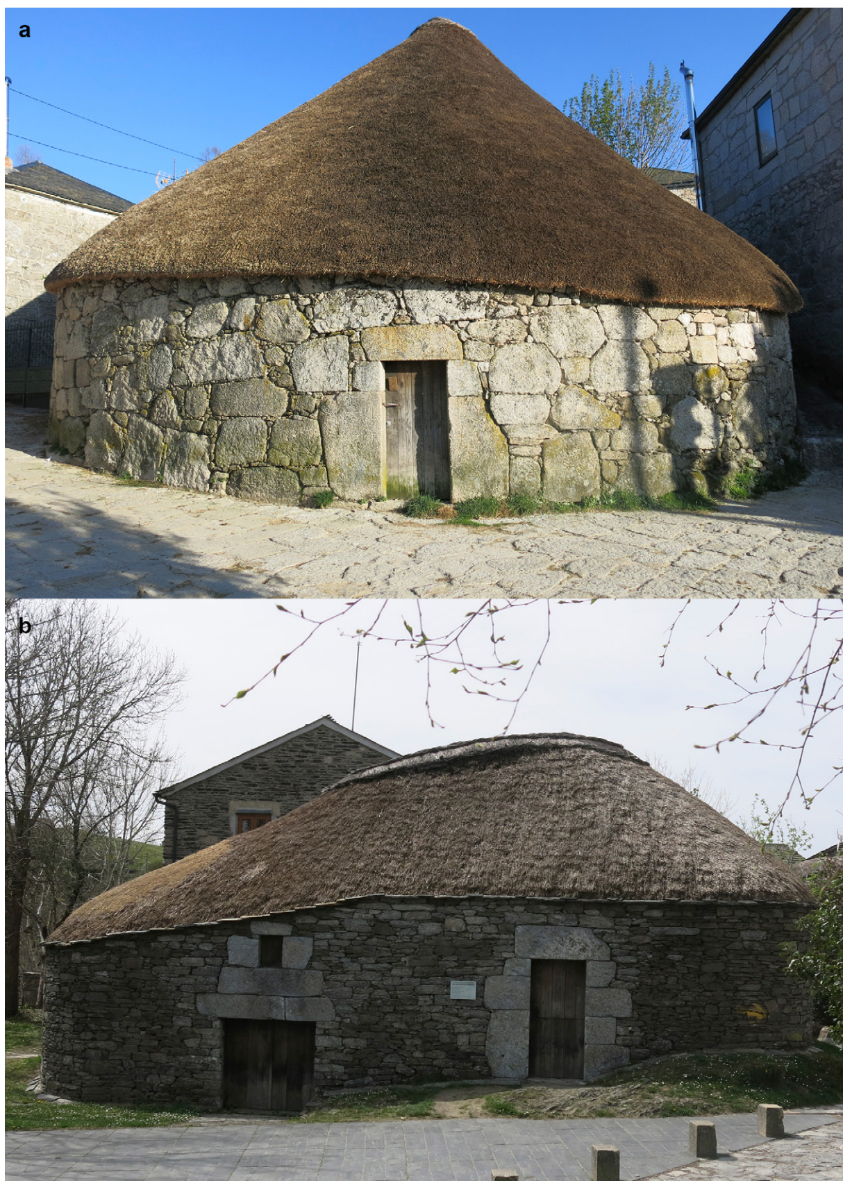
Figure 7. Rye straw thatching: a) palloza in Piornedo (Lugo) and b) palloza in O Cebreiro (Lugo).
