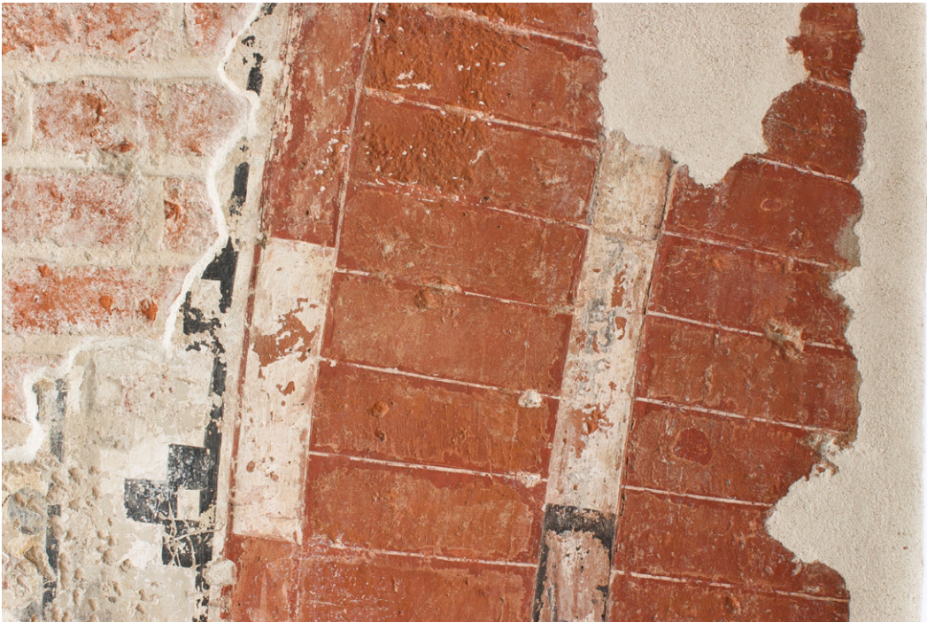
Figura 5. Milano, Santa Maria della Vittoria, dettaglio della ghiera dell'arcata centrale del presbiterio.
