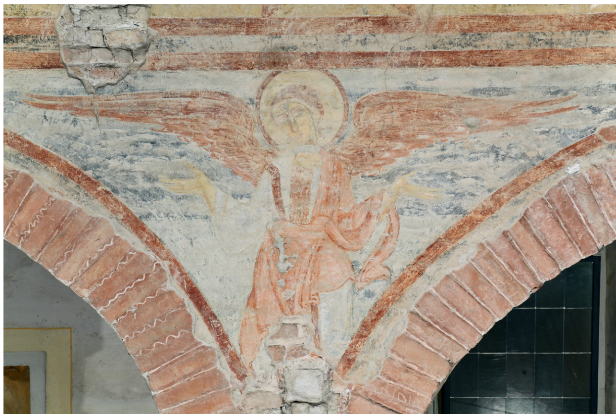
Figura 2. Acquanegra sul Chiese (Mantova), ex chiesa abbaziale di San Tommaso, navata, setto sud: sotto l'intonaco di XII secolo emerge la primitiva finitura delle ghiera laterizie.
