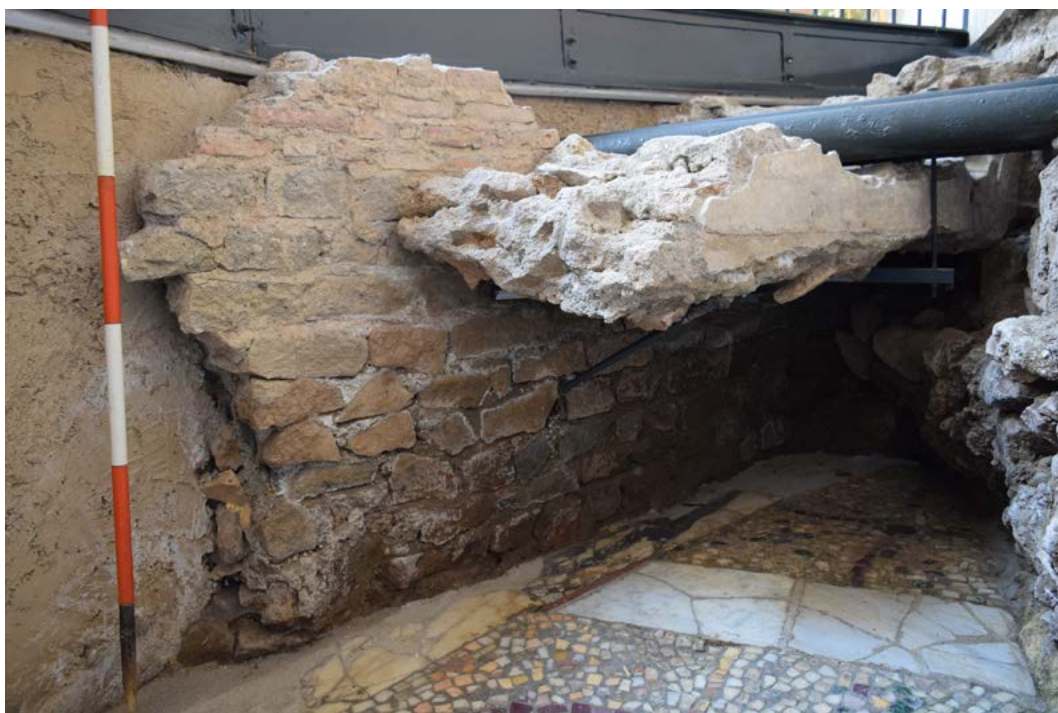
Figura 4 - Scavo 2021. Parete interna in ricorsi di mattoni su blocchetti di tufo contro terra dell'abside del primo quarto del XV secolo (foto dell'Autore).
