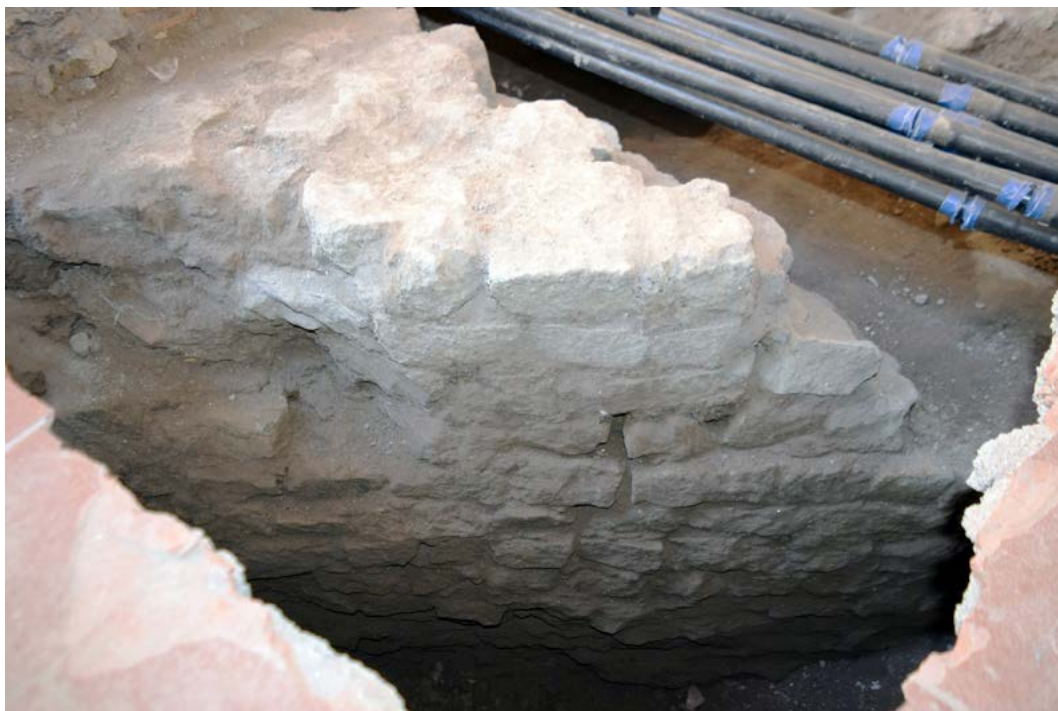
Figura 3 - Scavo 2021. Parete esterna a vista in blocchetti di tufo dell'abside del primo quarto del XV secolo (foto dell'Autore).
