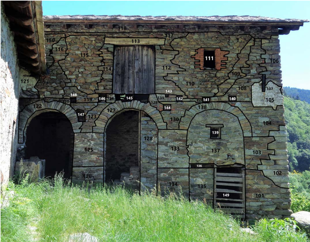
Figura 9 - P1 di San Bartolomeo con le USM evidenziate. Foto di S. Roberto.
