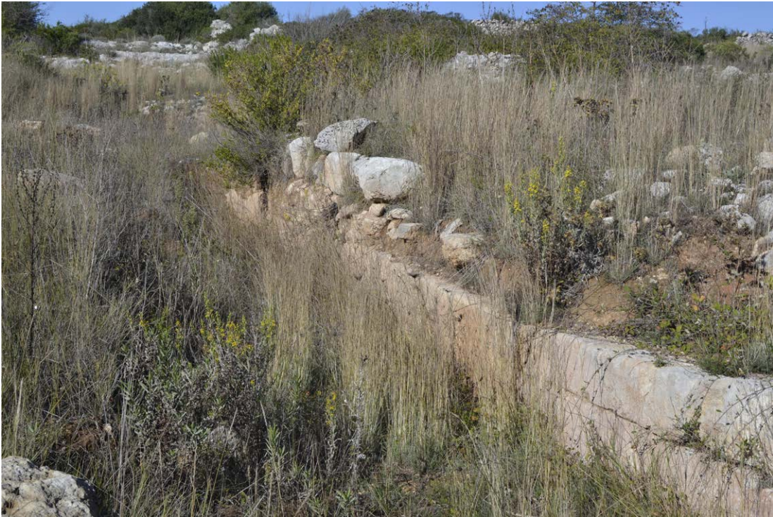
Figura 5 - Grottaglie (TA), lama La Torre. Resti del viadotto attraverso il quale la via Appia superava il dislivello all'interno dell'incisione torrentizia
