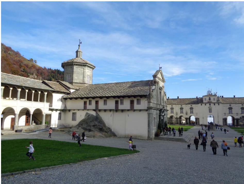
Figura 6 - Basilica Antica vista da Nord, con il deiro inglobato nella struttura, presso il quale sorse il Sacello Eusebiano. Foto di S. Roberto.
