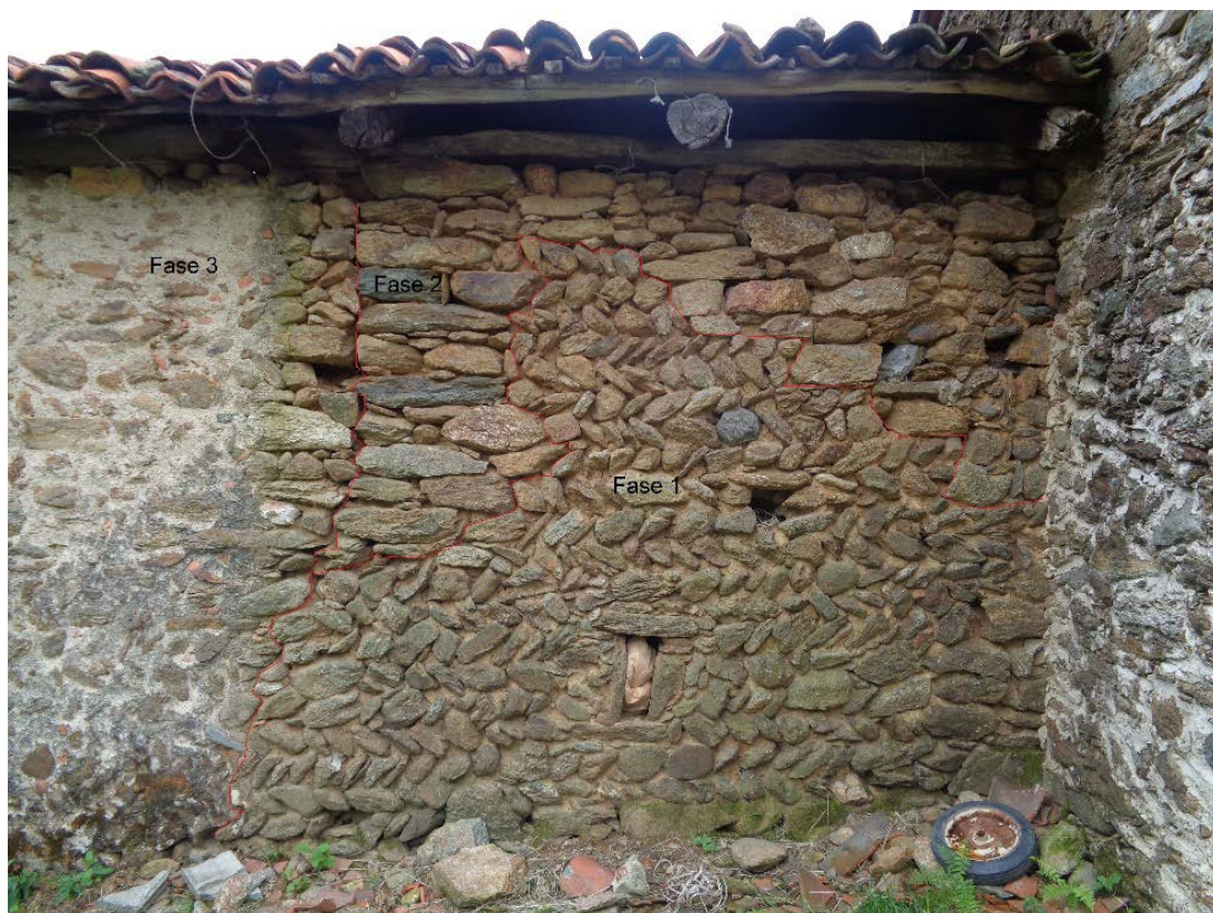
Figura 11 - P1 di cascina Gorneiro con le fasi evidenziate. Foto di S. Roberto.
