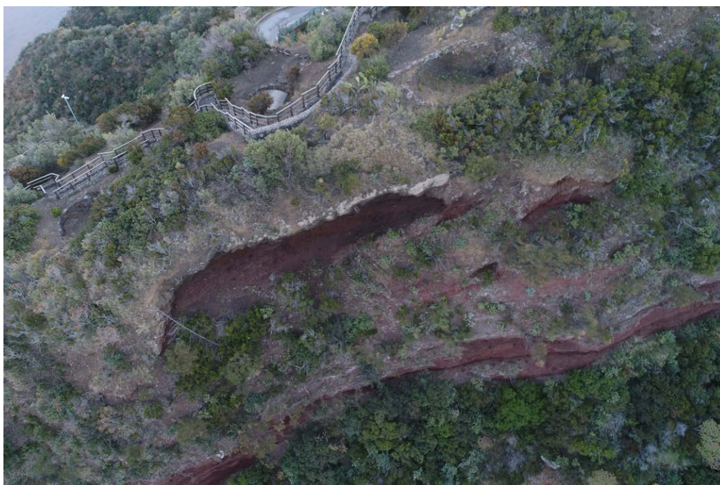
Figura 7 - Erosione eolica della parete Nord della cresta.
