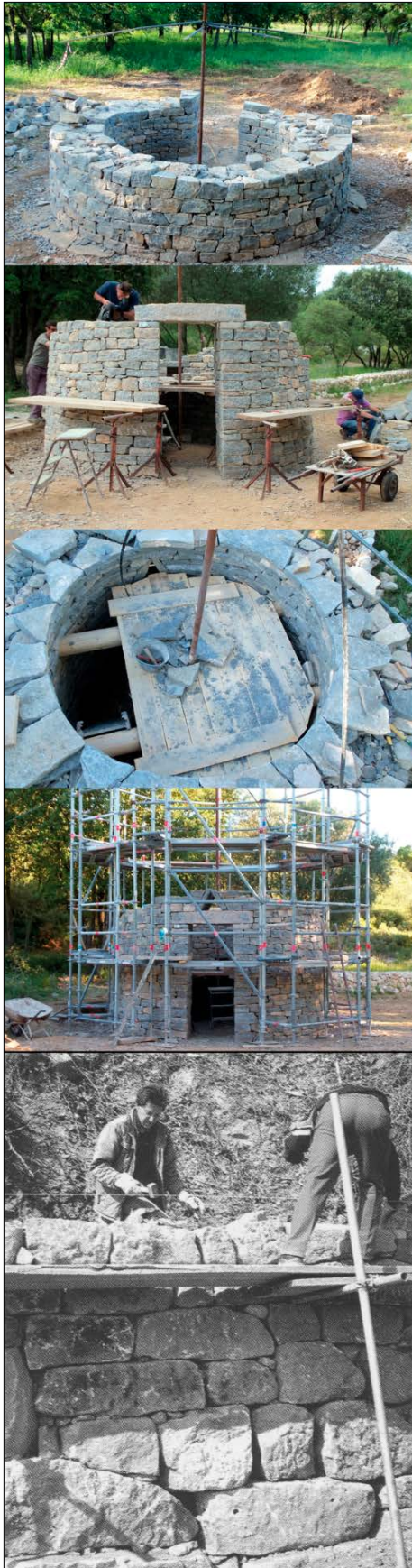
Figure II-28: Structures temporaires de chantier pour la construction d'une cabane (photos: Didier Rieux), bas: échafaudage pour le montage d'un mur de soutènement (d'après Lassure 2008).
