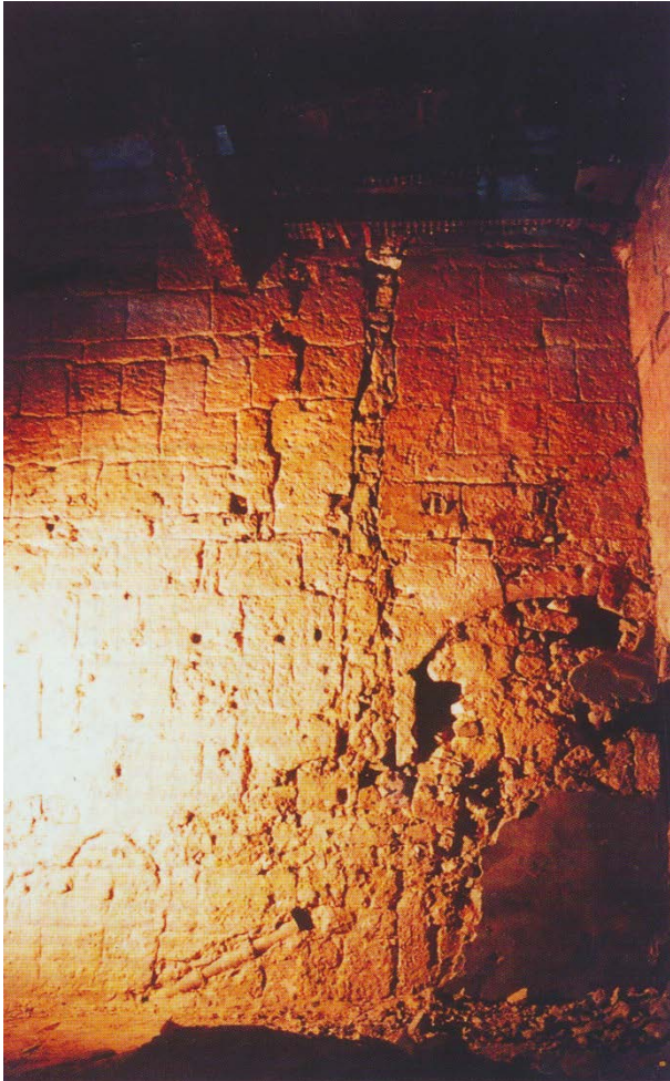
Figure II-7: Vue du mur ouest et l'angle nord-ouest de la maison 1, présence d'une césure verticale sur toute la hauteur, et d'un plafond peint conservé, daté du XIII e siècle (d'après Huser 2004).
