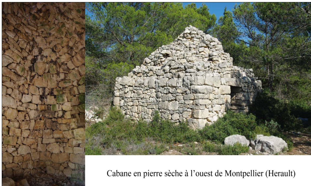
Figure I-59: Cabane de forme générale quadrangulaire contenant une voûte en encorbellement de base circulaire, la voûte n'a pas d'extrados.
