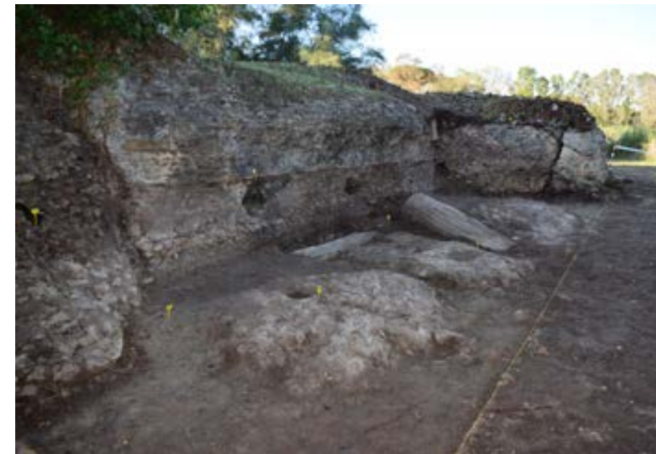
Figura 13. Sondeo de la fachada septentrional de la cabeza del muelle donde se constataron importantes elementos arquitectónicos y parte del derrumbe de la obra original.
