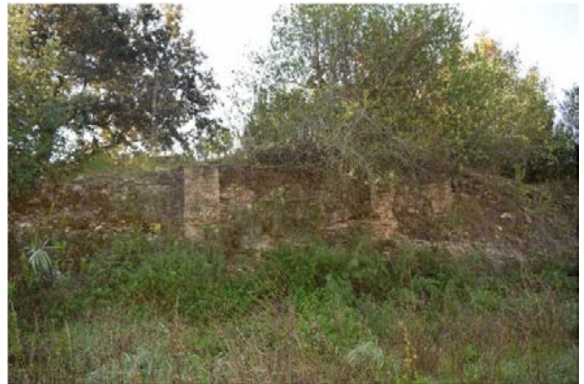
Figura 2. Estructuras en la zona superior del muelle.
