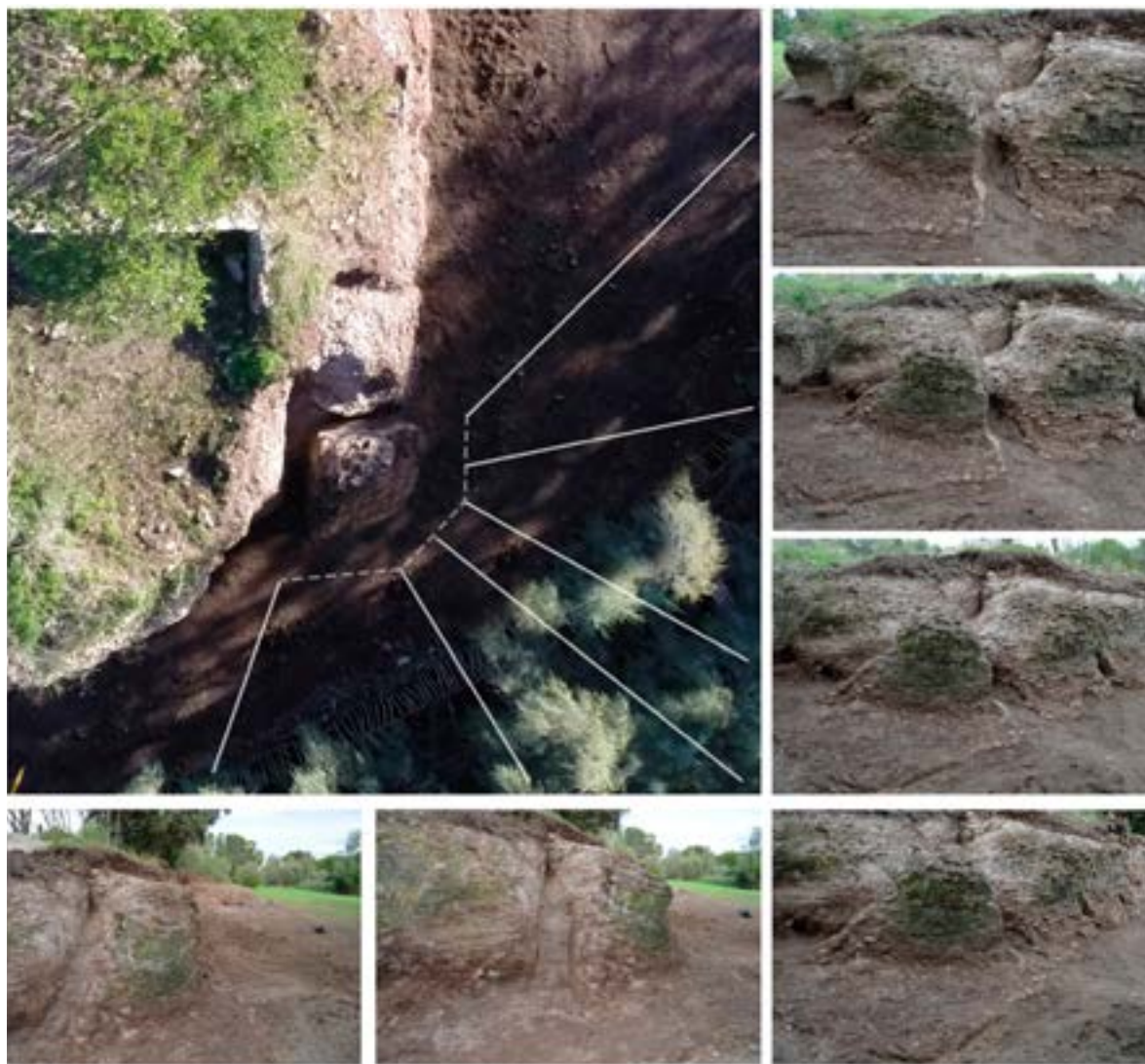
Figura 51. Vista general y de detalle de la fractura de la plataforma adosada.
