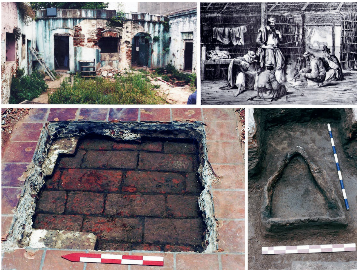
Figura 66. Casa de los últimos años del período colonial (calle San Juan 338) reconstruida a inicios del XIX. A la izquierda su fachada y el piso de ladrillos, a la derecha un ejemplo de un rancho de techo de paja y piso de barro, como debió ser esta, de lo que quedó el fogón en su centro.
