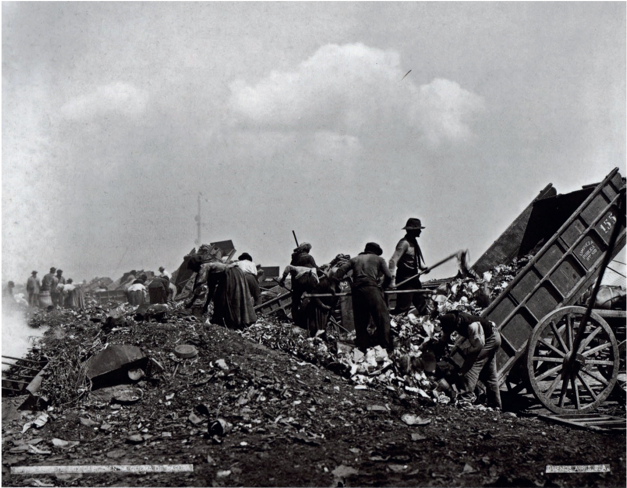
Figura 15. Descarga de residuos sobre capas preexistentes para concretar los rellenos: a medida en que se selecciona lo que se va a retirar, se va formando un nuevo estrato que luego será compactado (Biblioteca Manuel Gálvez).
