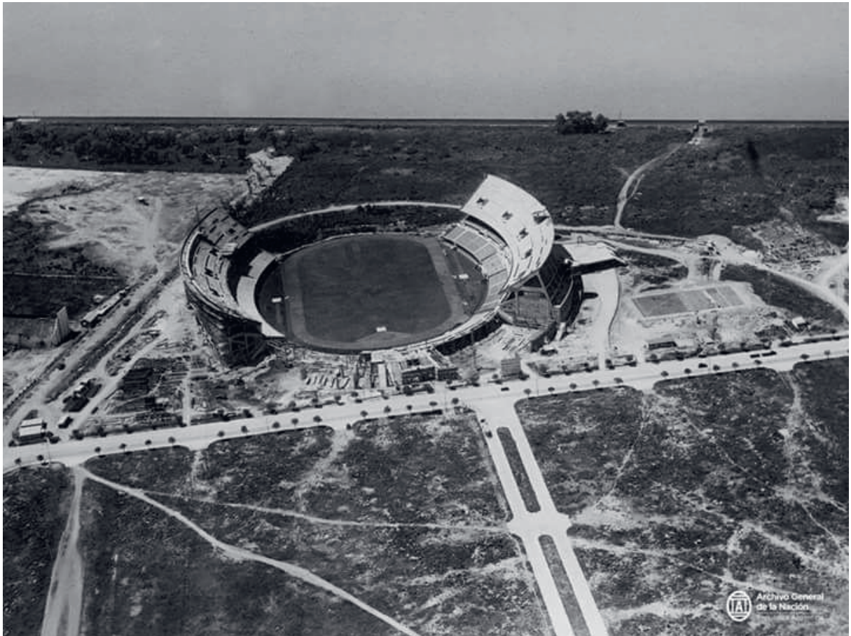
Figura 72. La cancha de fútbol de River Plate en 1936 durante su construcción sobre terrenos que fueron una laguna natural, rellena. Los alrededores en la fotografía aún no habían sido compactados (Archivo General de la Nación).
