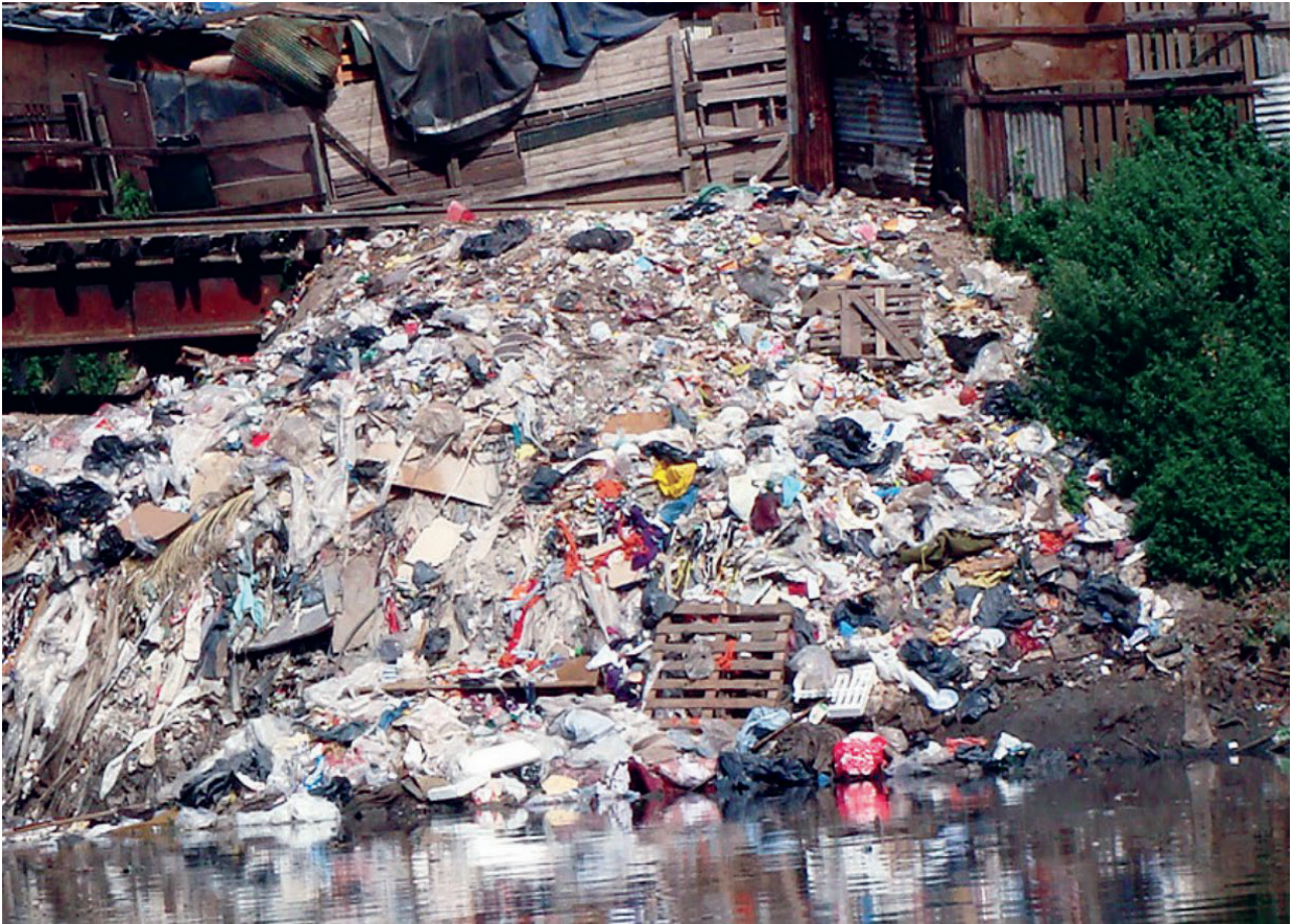
Figura 46. Barrio San Blas sobre el Riachuelo con un sector de la Villa 21 construida sobre rellenos de basura incluyendo un puente de ferrocarril ahora anulado (de: Igarzabal 2007: 46).
