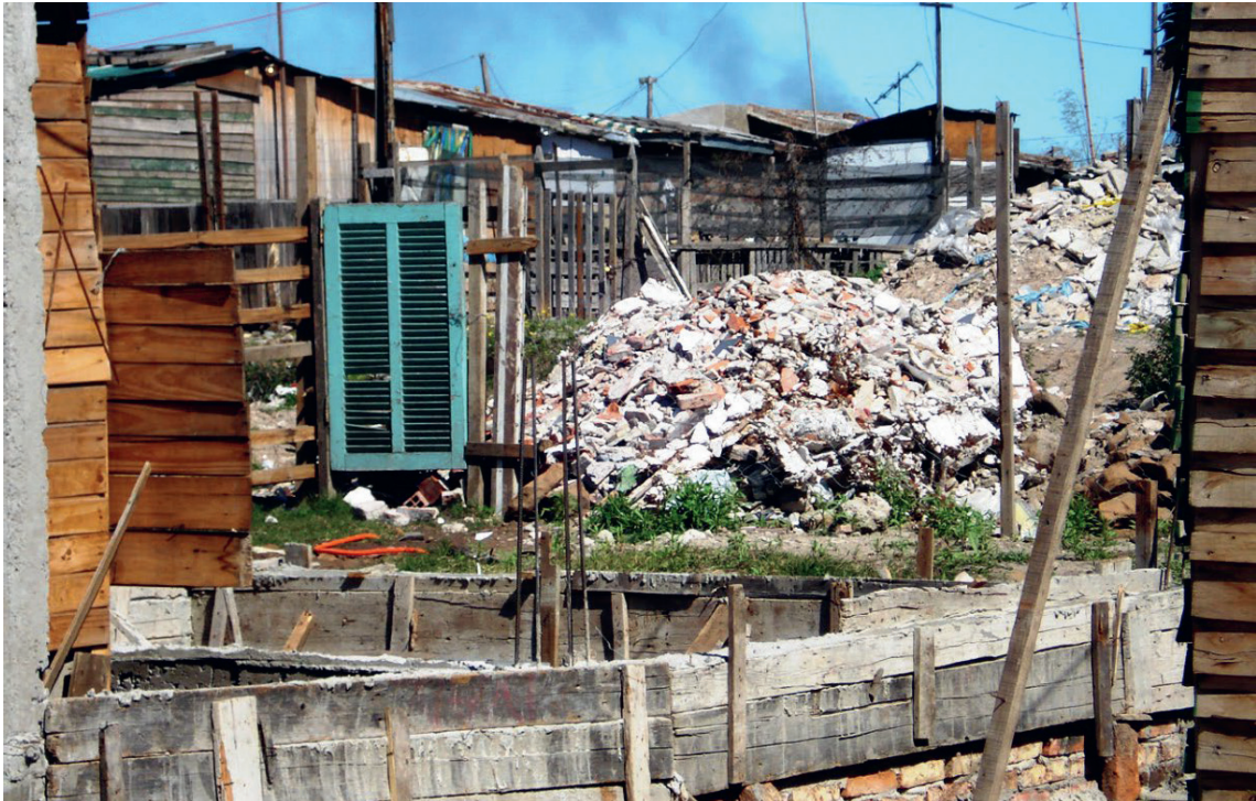
Figura 47. Etapas del proceso de asentamiento: los rellenos comienzan a presionar para que las construcciones existentes modifiquen su altura, permitiendo la entrada de mayor volumen de desechos, Barrio Miró en Lomas de Zamora (de: Igarzabal 2012: 46).
