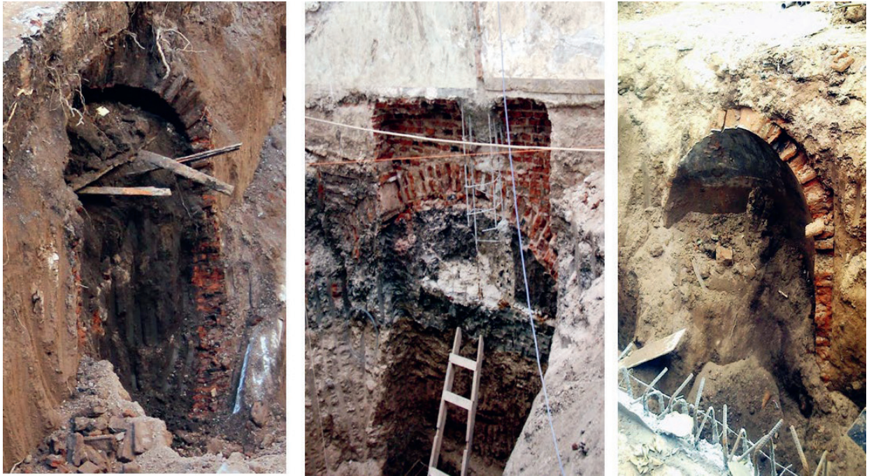
Figura 78. Los problemas de la arqueología en las obras comenzadas: las habituales cisternas en los cimientos medianeros cortadas al medio en Buenos Aires. Con bajas posibilidades de estudio por el evidente riesgo de derrumbe o los altos costos para estabilizarlas. Un final de destrucción es imposible de evitar. Es buen ejemplo del desafío a la arqueología que se produce en las ciudades de destrucción sin control.
