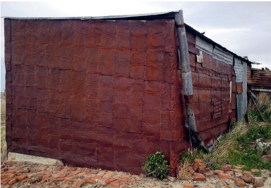
Figura 27. Casa hecha con las mismas latas que en la fotografía anterior, en este caso desplegadas, aún en pie en Puerto Santa Cruz.
