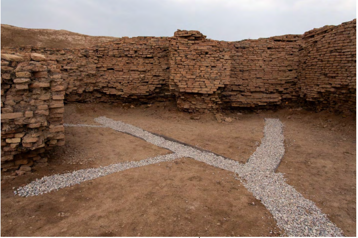
شكل 26.7 قناة تصريف نُصبت لتصريف المياه من الجسر في تلو
