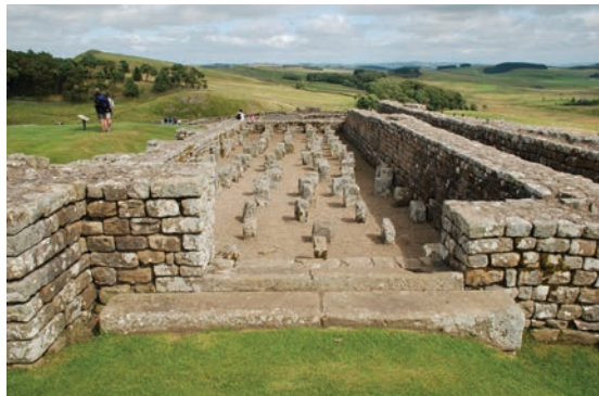
148. The granary at Housesteads. The timber floor was supported on the short pillars Das Getreidelager von Housesteads. Der Holzboden wurde von kurzen Pfeilern gestützt L'entrepôt à Housesteads. Le plancher en bois était soutenu par les piliers bas
