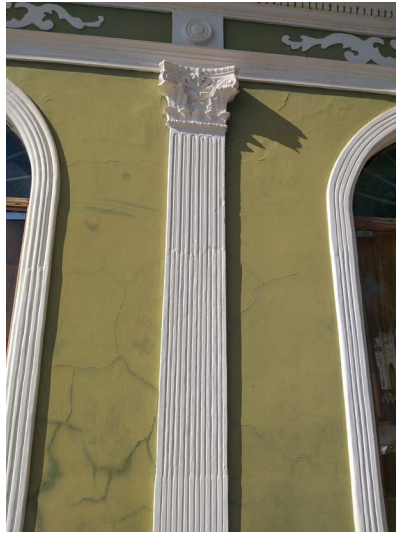
Figura 14: Capitel de estilo corintio situado en la fachada de una tienda de la calle Manoel Cavassa. Fuente: Colección privada de la autora. 2022.
