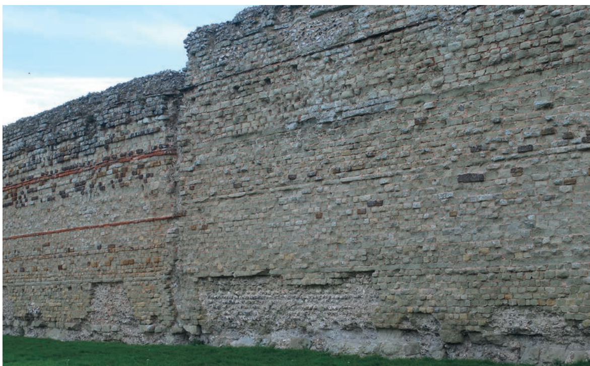
121. Curtain wall at Pevensey showing the work of different work gangs Courtines à Pevensey et l'œuvre des diverses équipes de chantier
