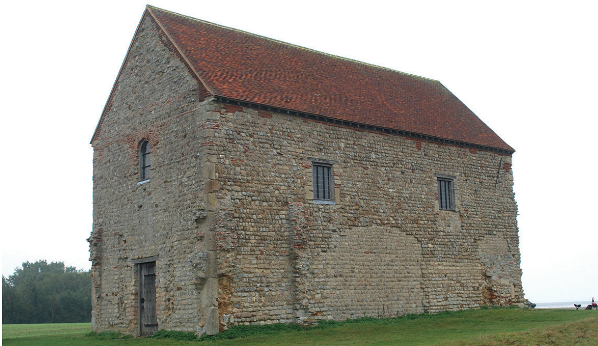
108. The 7th-century church of St Peter ad Murus , Bradwell L'église de St Peter ad Murus du VIIe siècle à Bradwell
