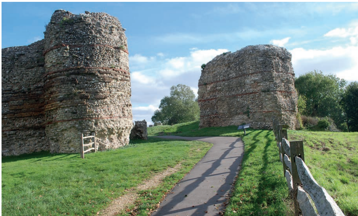
120. West gate of Pevensey with flanking bastions Porte ouest de Pevensey flanquée de ses bastions
