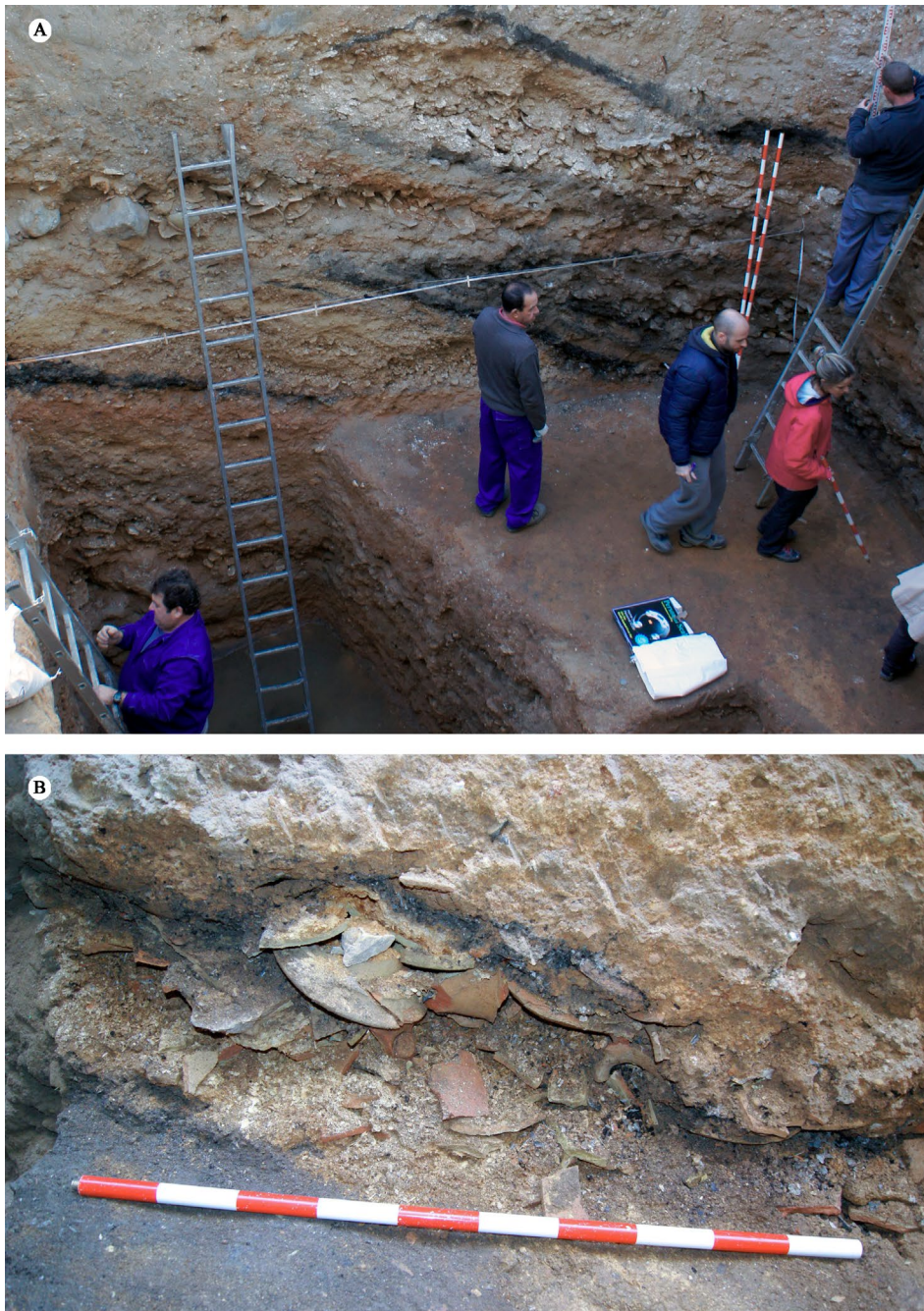
Figura 19. Vista general desde el sureste de los estratos de termoalteración de la ictiofauna (A), con detalles de algunos de ellos, entremezclados con las descargas anfóricas (B. U.E. 3019).
