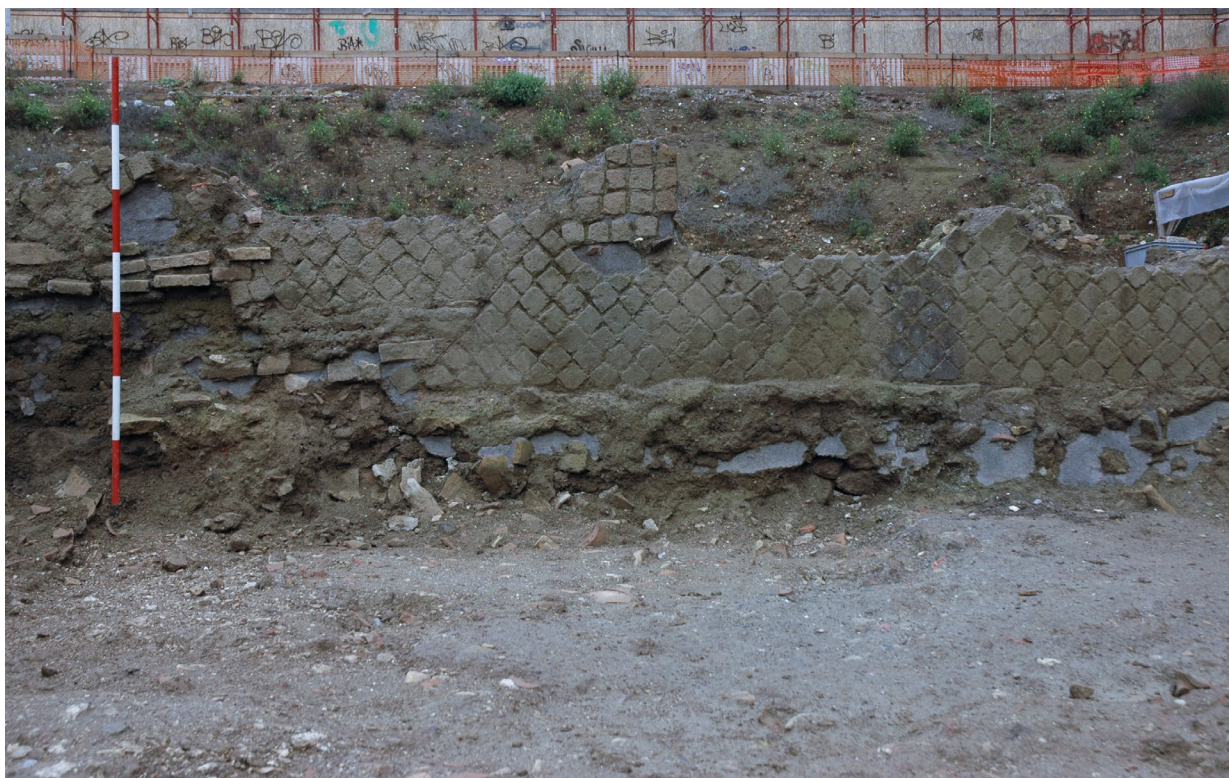
Figura 7. Nuovo Mercato Testaccio. Settore nordorientale. Muro in opera reticolata. Particolare della muratura con restauro successivo di un blocco di cubilia disposti in filari orizzontali (foto D. Putorti).
