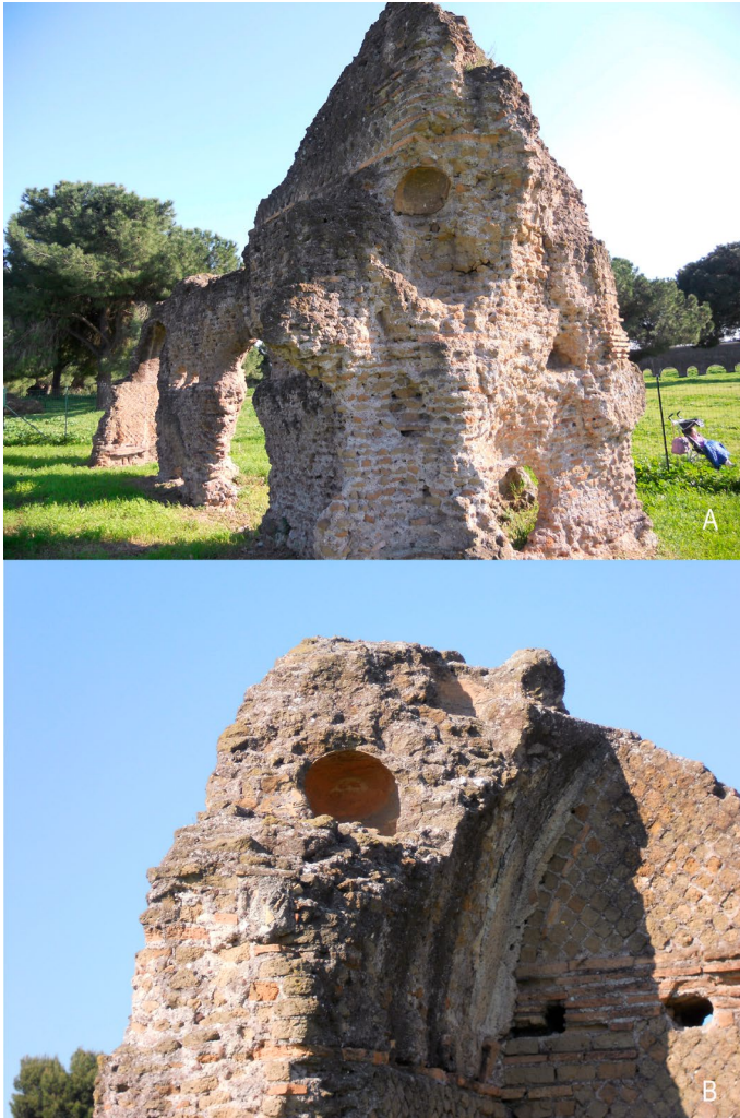
Figura 3. Roma, Villa delle Vignacce. Esempi di reimpiego di anfore in ambito costruttivo (foto L. D'Alessandro).
