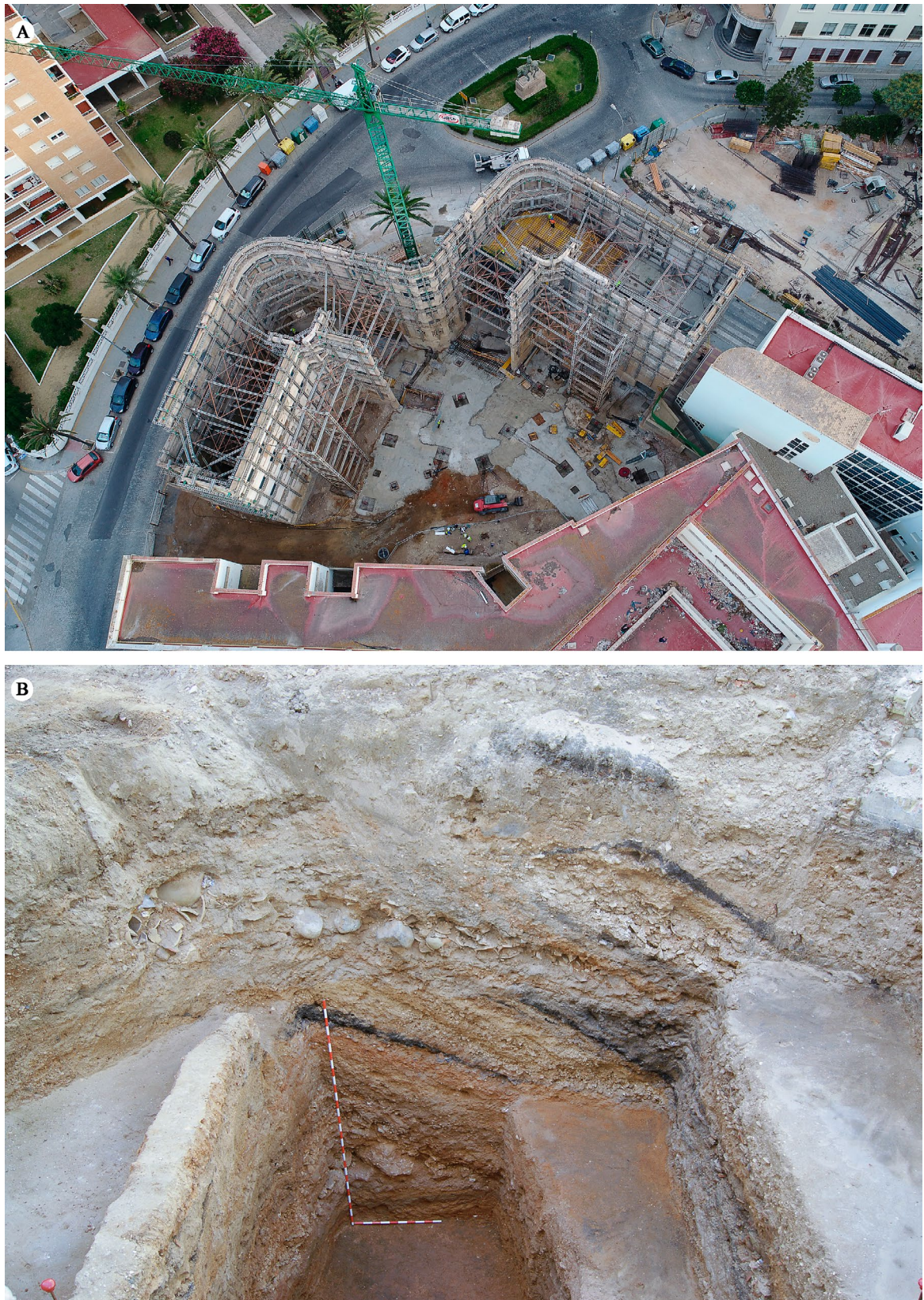
Figura 1. Vista aérea de El Olivillo durante el proceso de rehabilitación, con la parte trasera del mismo donde se ejecutaron las excavaciones arqueológicas (A. Foto LABAP-Universidad de Cádiz); y detalles del perfil noroccidental de la secuencia estratigráfica (B).
