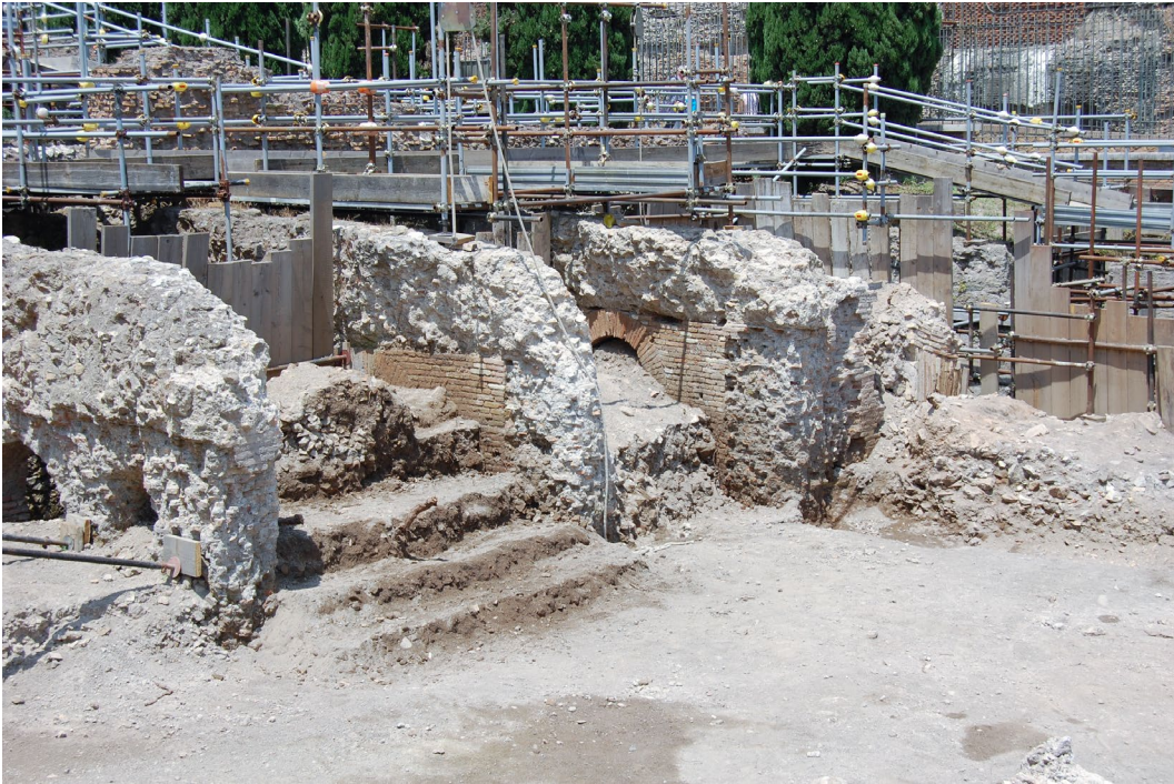
Figura 10. Roma. Palatino. Riempimenti in funzione di rafforzamento delle sostruzioni (per gentile concessione M. Casalini, F. Coletti).
