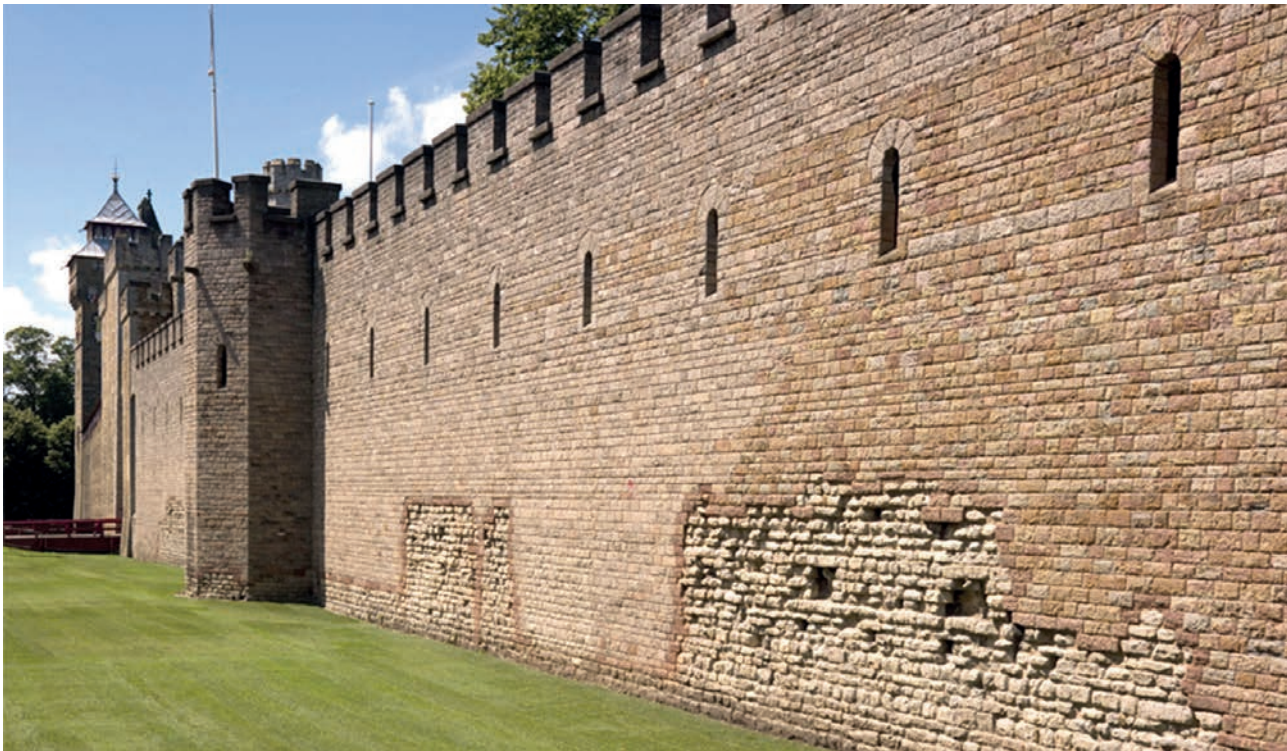
66. Cardiff: photograph of the Roman and later walls at Cardiff Castle Caerdydd: llun o furiau Rhufeinig a muriau diweddarach yng Nghastell Caerdydd
