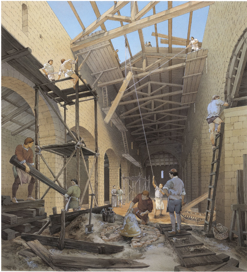
Figura 3: Il cantiere della chiesa di Sant'Agnese (InkLink)
