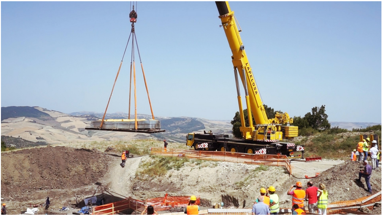
Figura 3: Trasferimento in blocchi della capanna (circa 20 tonnellate l'uno) in un'area fruibile e sorvegliata nel centro di SanChirico Nuovo (PZ)
