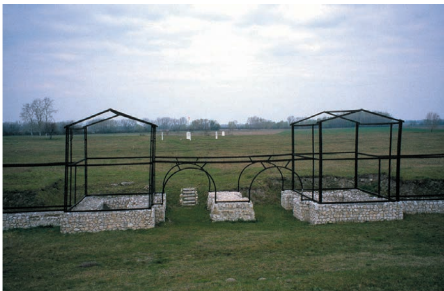
53. At Iža (Slovakia) an impression of the south-gate is provided by the timber sculpture 53. Na lokalitetu Iža (Slovačka) rekonstrukciju južne kapije pruža struktura izrađena od drveta
