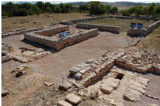
Figura II.14. Conjunto bautismal ya restaurado
