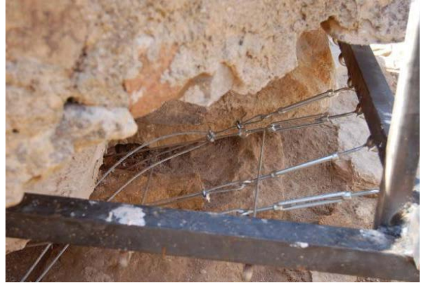
Figura II.5. Detalle de la colocación de los tensores
