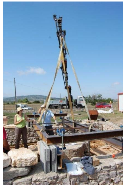
Figura II.7. Levantamiento con grúa de la piscina bautismal
