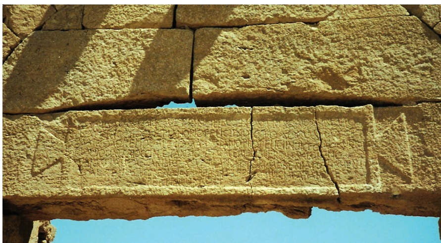
21. Véssett építési felirat Quasr-Aseikhin későrómai erőd kapujának gerendáján (architrav) – fotó Visy Zs.
