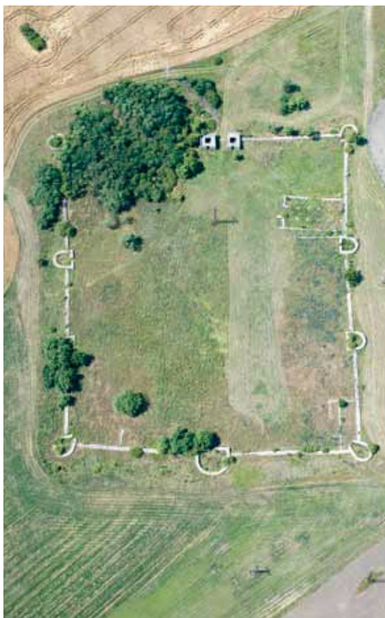
59. The preserved remains of the late Roman fort at Tokod are situated a few kilometres south of the river Danube (Hungary) Die erhaltenen Ruinen des spätrömischen Kastells Tokod liegen einige Kilometer südlich des Donaulaufes (Ungarn) Zachované ruiny neskororímskeho kastelu v Tokode ležia niekoľko kilometrov južne od Dunaja (Maďarsko)
