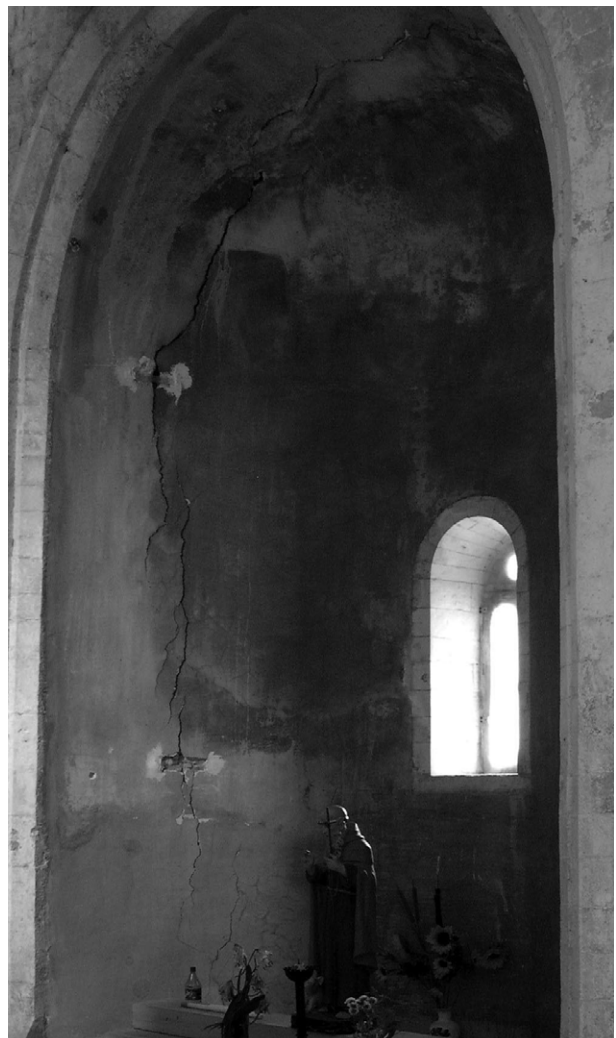
115. S. Salvatore di Valdicastro. Abside nord.
