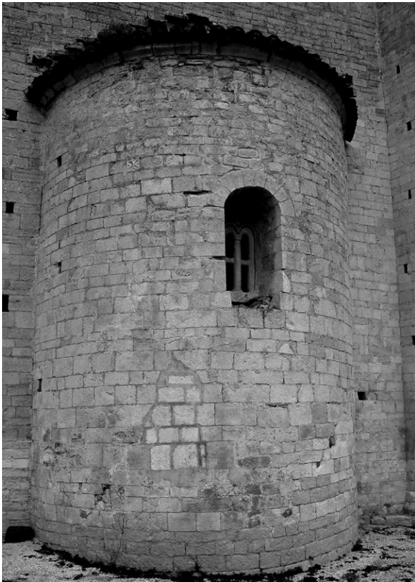
112. S. Salvatore di Valdicastro. Abside laterale sud.
