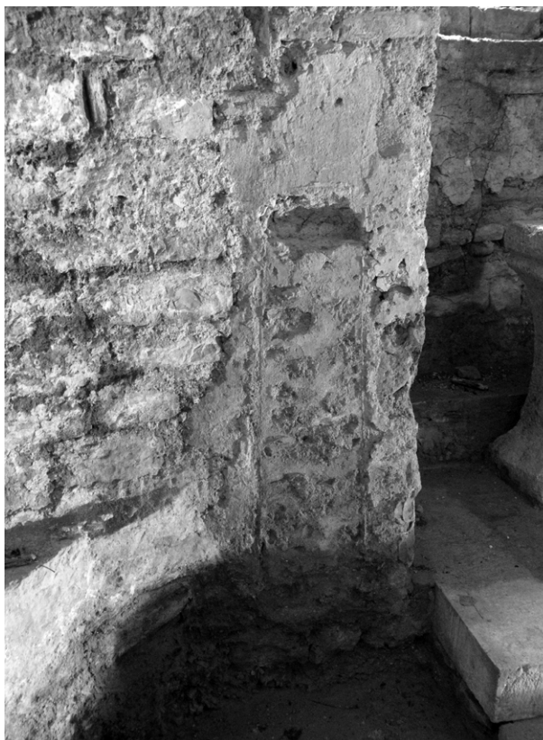
104. S. Salvatore di Valdicastro, cripta. Navata laterale nord. Tracce di alloggiamento di un probabile cancello che separava la zona dell'altare dal collaterale. Le stesse tracce sono rimaste nella testata del collaterale sud.
