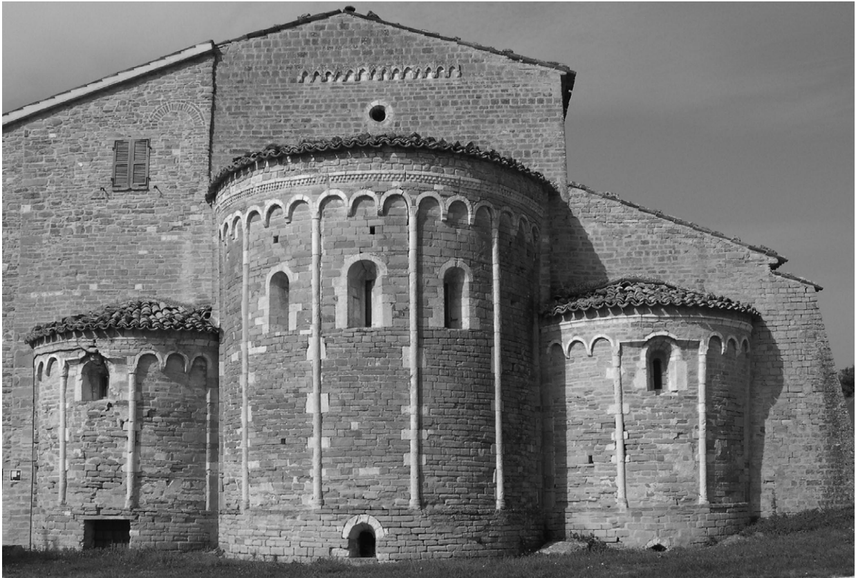
46. Apiro, S. Urbano. La zona absidale.
