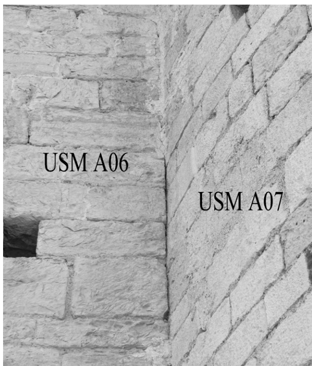
116. S. Salvatore di Valdicastro. Particolare del lato orientale. Le pietre della testata sud si appoggiano all'abside laterale sud.
