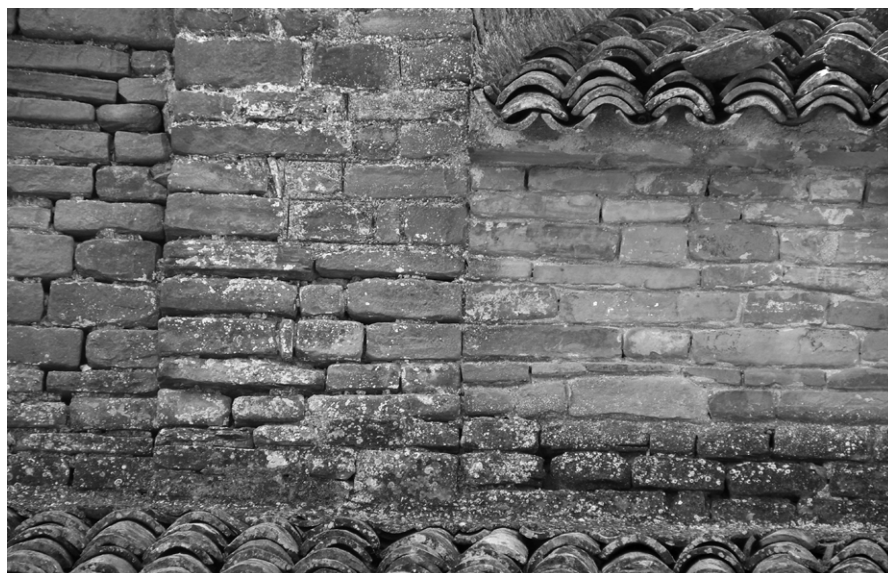
67. S. Urbano all'Esinante. Parete nord della navata centrale del coro (a sinistra) e quella della chiesa dei laici (a destra). Si nota molto bene la sovrapposizione più irregolare della seconda che è successiva.
