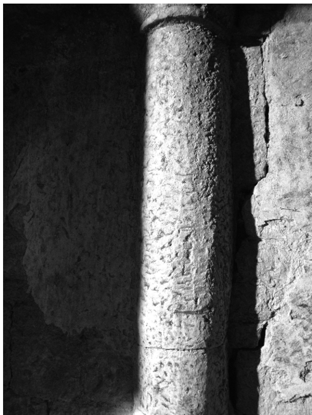
134. S. Maria di Valfucina, cripta. Semicolonna della parete nord.
