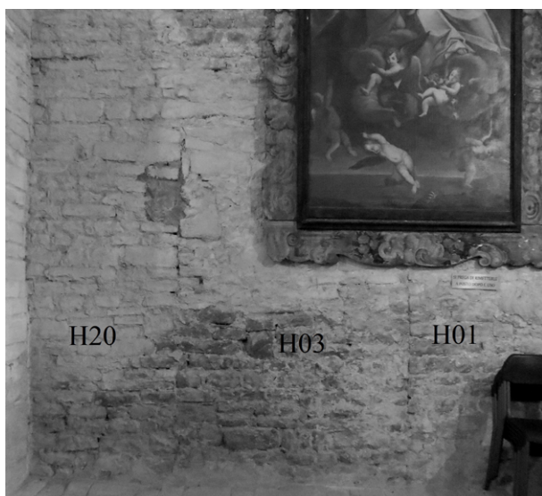
23. S. Elena all'Esino. Particolare della parete sud, terza campata. Si nota ancora il portale di fase 1 successivamente tamponato (USM H03).
