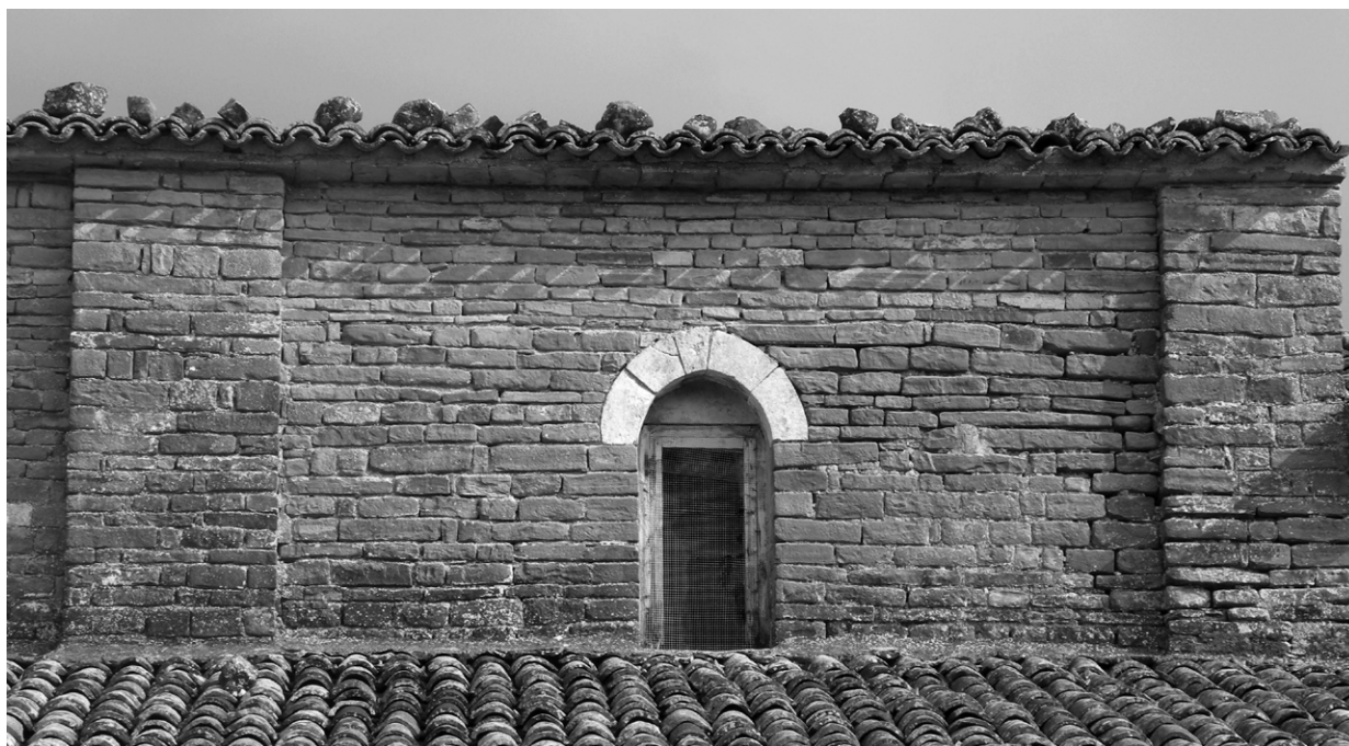
60. S. Urbano all'Esinante. Parete esterna nord della navata centrale del coro in corrispondenza della prima campata.
