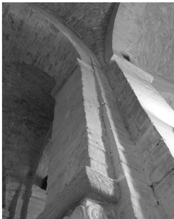
37. S. Elena all'Esino. Particolare del terzo pilastro nord della navata centrale (pilastro 17). In alto la lesena del lato ovest si allarga fino a giungere a filo con l'arco di fase 2.
