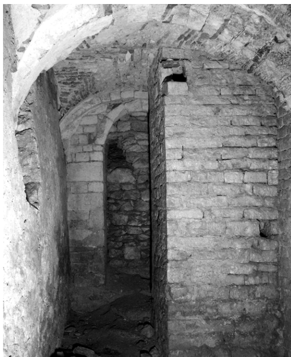
131. S. Maria di Valfucina, cripta. La navata nord vista da est. Sullo sfondo l'ingresso originario, a sinistra l'ossario, a destra il pilastro del XIII secolo.
