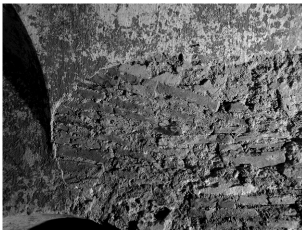
102. S. Salvatore di Valdicastro, cripta. Navata centrale. Punto di raccordo tra la volta a botte e la voltina a crociera.
