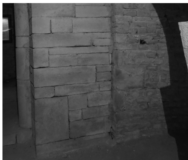
18. S. Elena all'Esino. Pilastro di fase 2 che si appoggia allo spigolo nord dell'abside della cripta.
