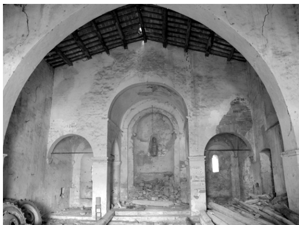
150. Cingoli, Ss. Quattro Coronati. La zona presbiteriale vista da ovest.
