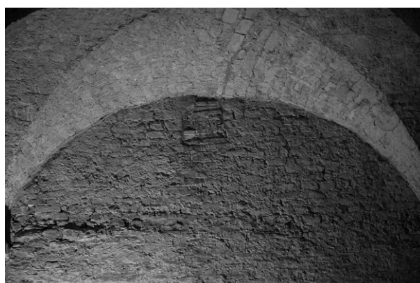
33. S. Elena all'Esino. Zona superiore della parete sud del presbiterio. In alto è visibile la finestra tamponata.
