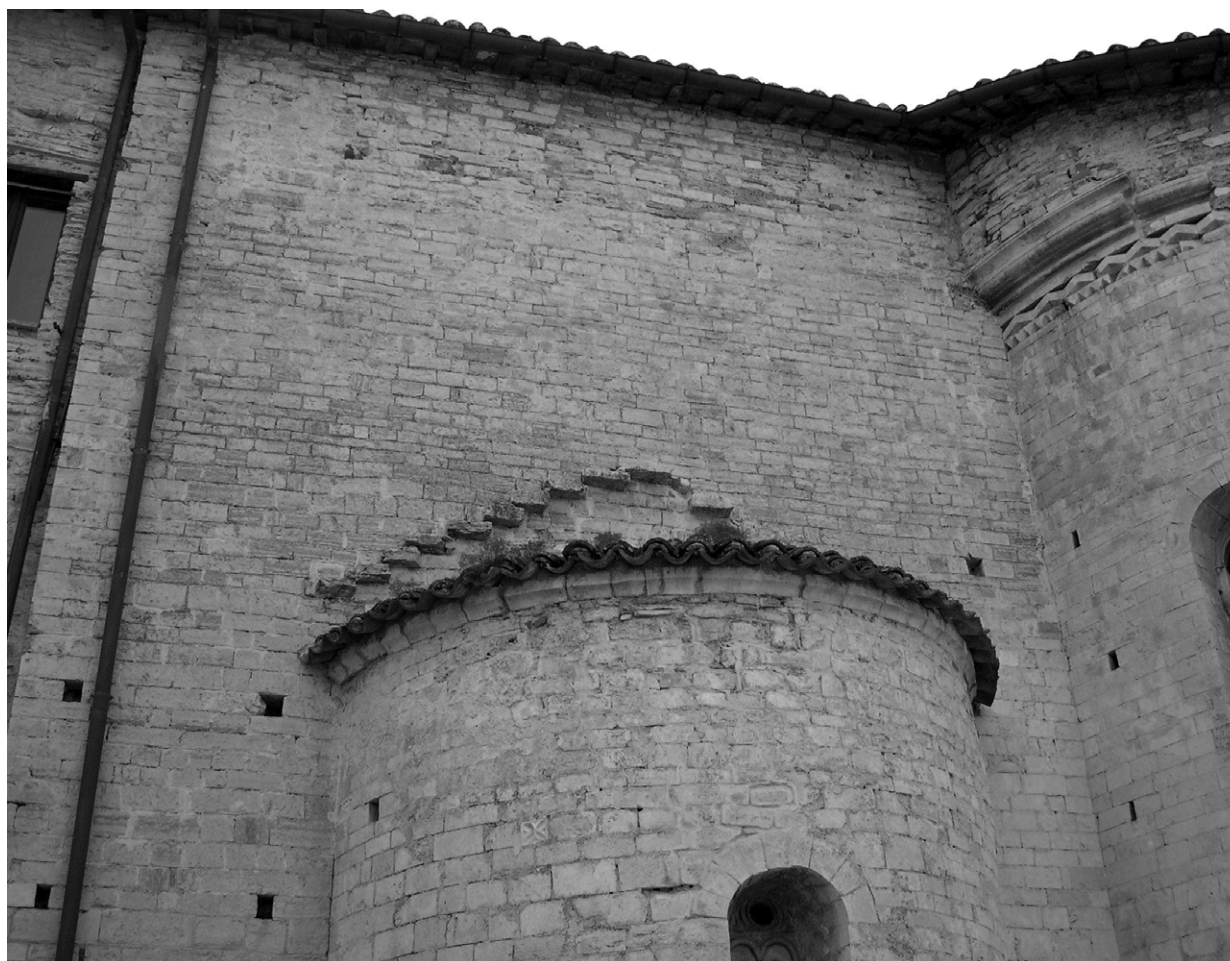
107. S. Salvatore di Valdicastro. Particolare della parete sopra l'abside laterale sud.
