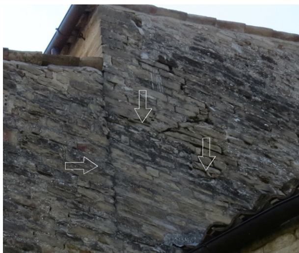
16. S. Elena all'Esino. Zona superiore del lato est, sopra l'abside. A destra dell'allineamento verticale di pietre è visibile una porzione della parete di fase 1.
