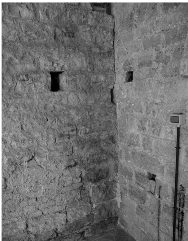
118. S. Salvatore di Valdicastro. La parete sud della navata (a sinistra) si appoggia al muro del transetto.
