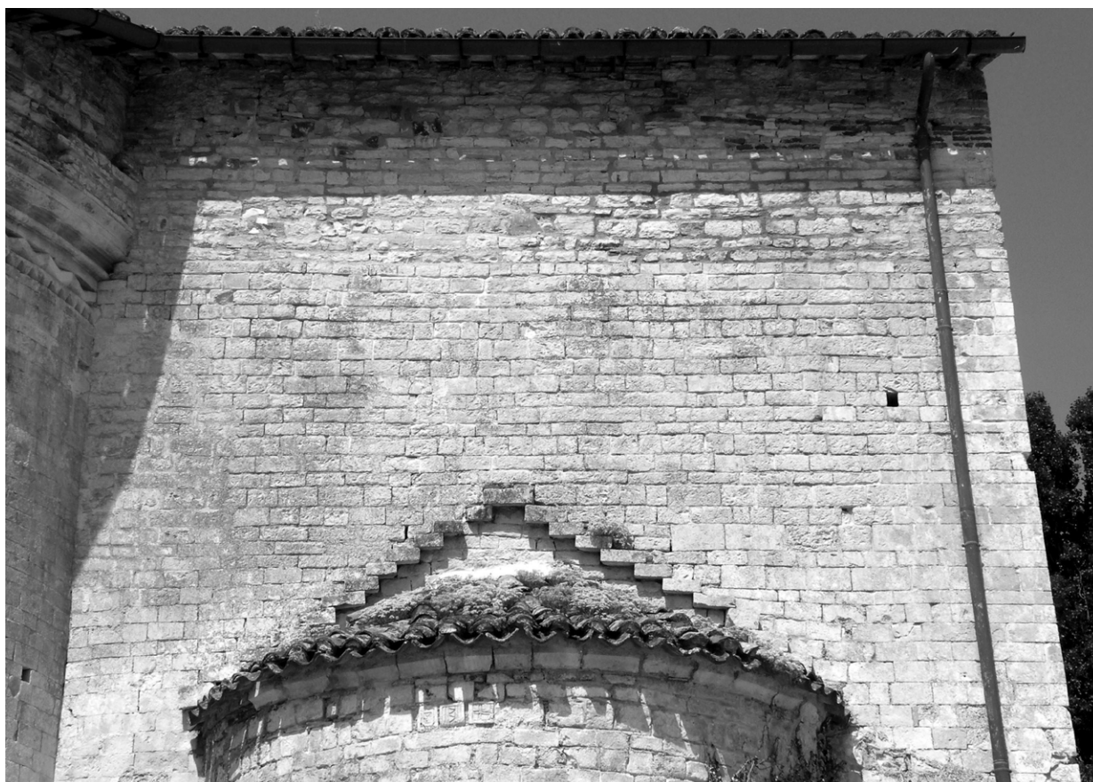
109. S. Salvatore di Valdicastro. Particolare della parete est sopra l'abside laterale nord.
