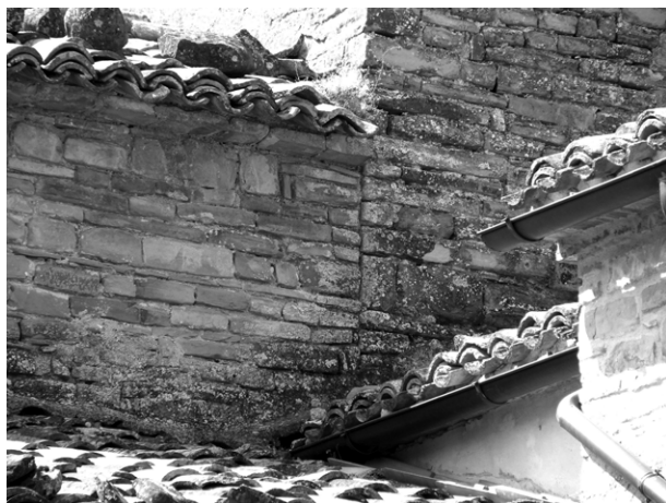
68. S. Urbano all'Esinate, parete sud nella navata centrale. A sinistra la chiesa dei laici, a destra la torre. La muratura della prima si appoggia a quella della torre, che dunque è precedente.
