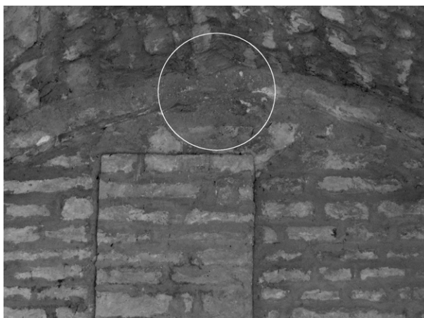
71. S. Urbano all'Esinate. Sommità del tramezzo, lato ovest. Restituzione della posizione dell'oculo sulla base dei conci superstiti.
