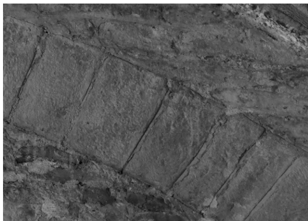
36. S. Elena all'Esino. Particolare di uno degli archi superiori della navata centrale.
