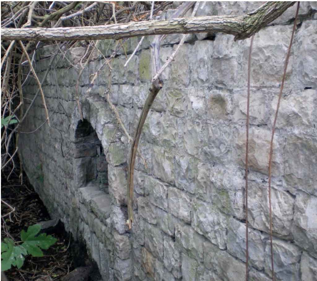
Figura. 46. Ingresso della struttura ipogea (P. Marino).
