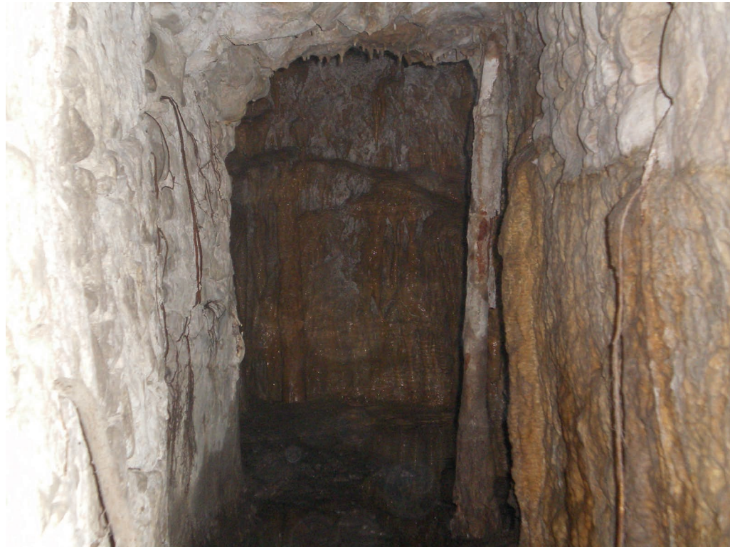
Figura. 49. Vista di uno scendente in tubi di terracotta (P. Marino).
