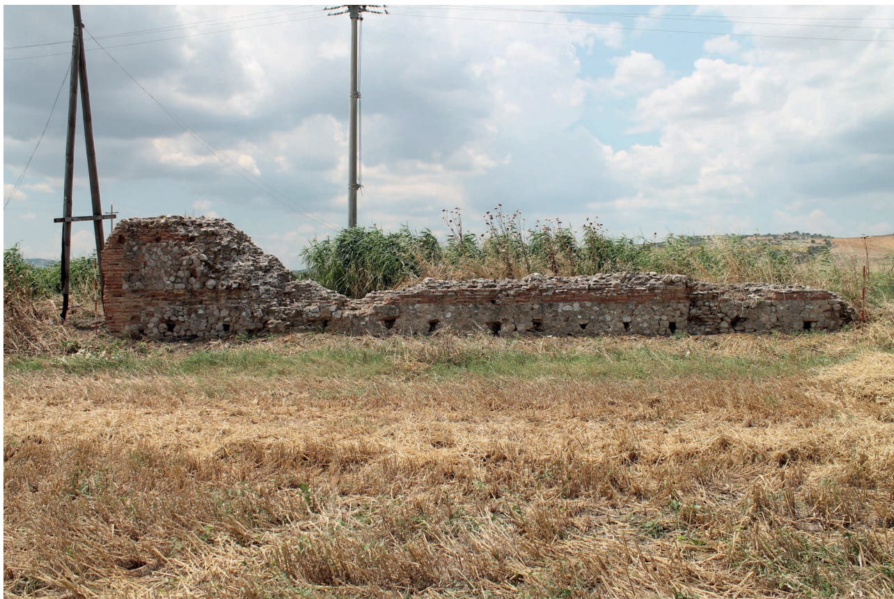
Figura. 41. Pilastro di depressurizzazione (a sinistra) e parte del condotto conservato (a destra) (Foto P. Marino).
