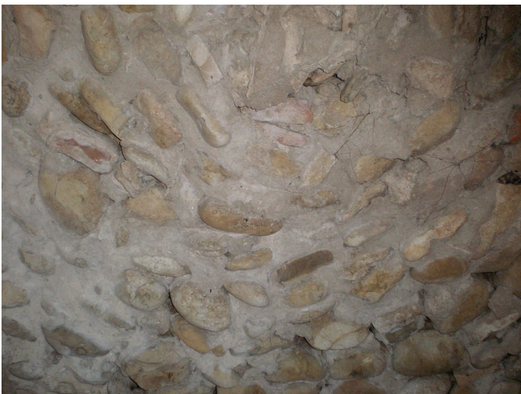
Figura. 48. Particolare della muratura della volta della vasca (P. Marino).
