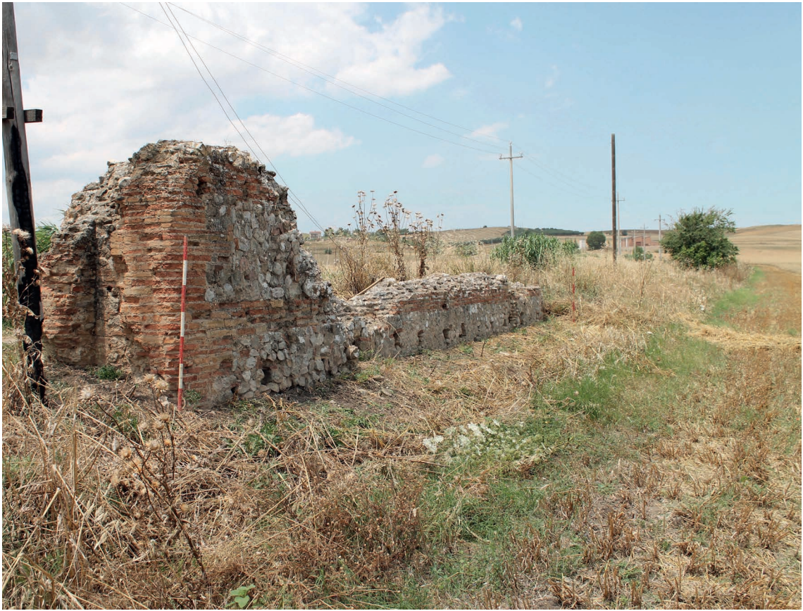
Figura. 5. Parte del condotto in opus mixtum dell'acquedotto romano di Melanico (foto P. Marino).
