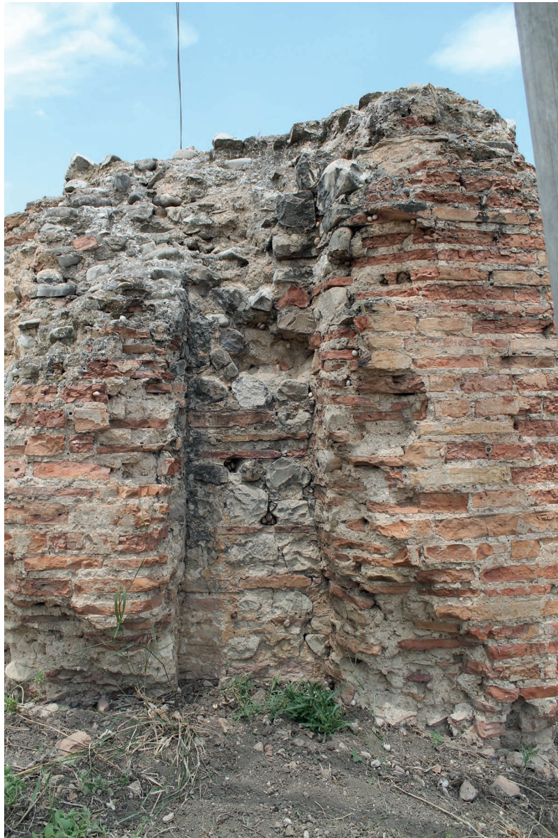
Figura. 43. Particolare del pilastro di depressurizzazione, con canaletta centrale (Foto P. Marino).
