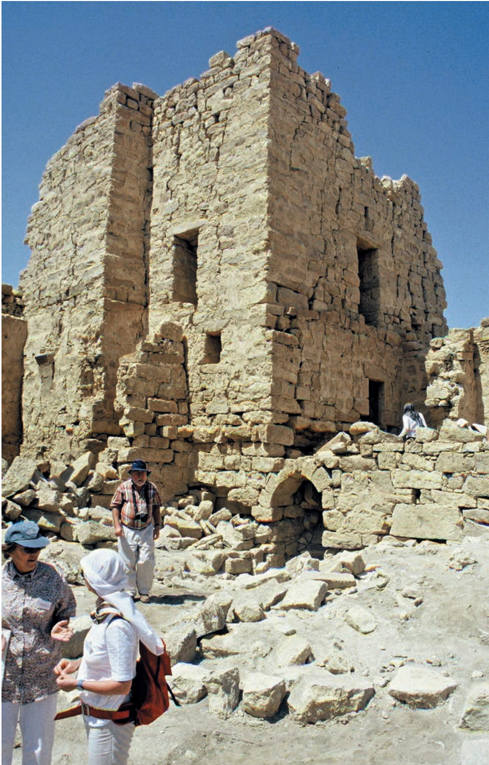
3. Fortification and corner tower at the fort of Gasr Bishr (Jordan) Befestigungsanlage und Eckturm des Kastells Gasr Bishr (Jordanien)
