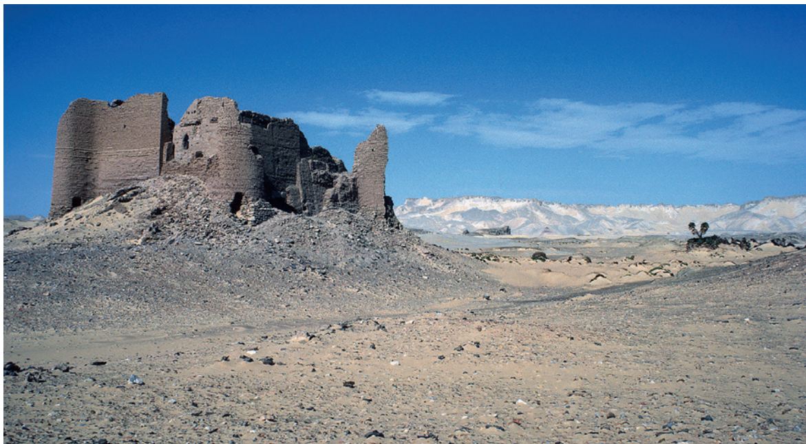
143. The fort at Ain Labakha in the Khargeh oasis. The late curtain wall encloses an earlier tower Le fort de Ain Labakha, dans l'oasis de Khargeh. La courtine tardive enserre une tour précédente
