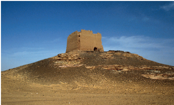
141. The fortress at el-Gib in the Khargeh oasis La forteresse de el-Gib, dans l'oasis de Khargeh
