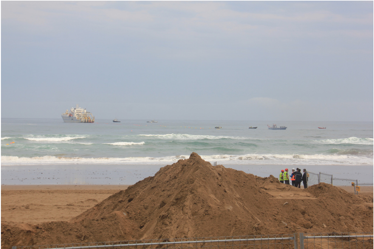
Figura 6.1.3. Instalación del cable submarino entre España (en su entrada por Sopelana, Bizkaia) y Estados Unidos. Esta actuación contó con un control arqueológico del proceso en aguas de Bizkaia. Foto J. M. Matés Luque.
