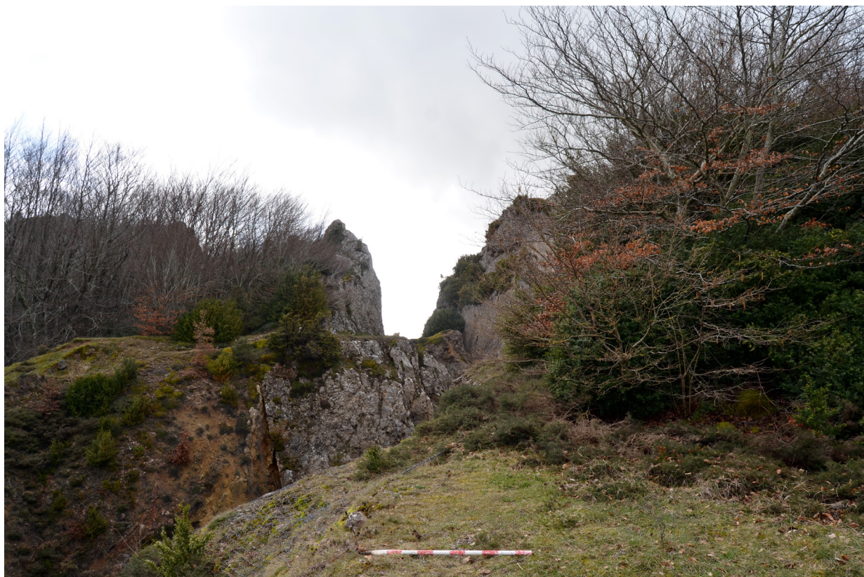
Figura 5.1.5. Restos de la trinchera del puerto viejo de Lapoblación. Pueden apreciarse restos de explanación y el corte resultante de la construcción de la carretera actual. Autora: Estibaliz Aguirre.
