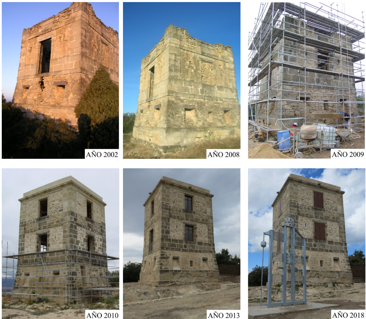
Figura 5.2.1. Evolución de la torre desde el año 2002 hasta la actualidad y proceso de restauración seguido. (Imágenes: autor).
