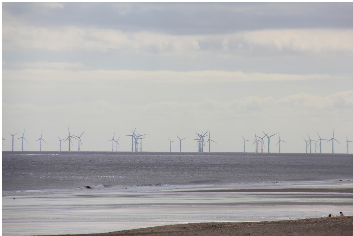
Figura 6.1.5. Aerogeneradores marinos en Skegness (Reino Unido). La instalación de estos elementos cuenta con informes previos de valoración medioambiental en donde la arqueología subacuática juega un papel destacado. Foto J. M. Matés Luque.
