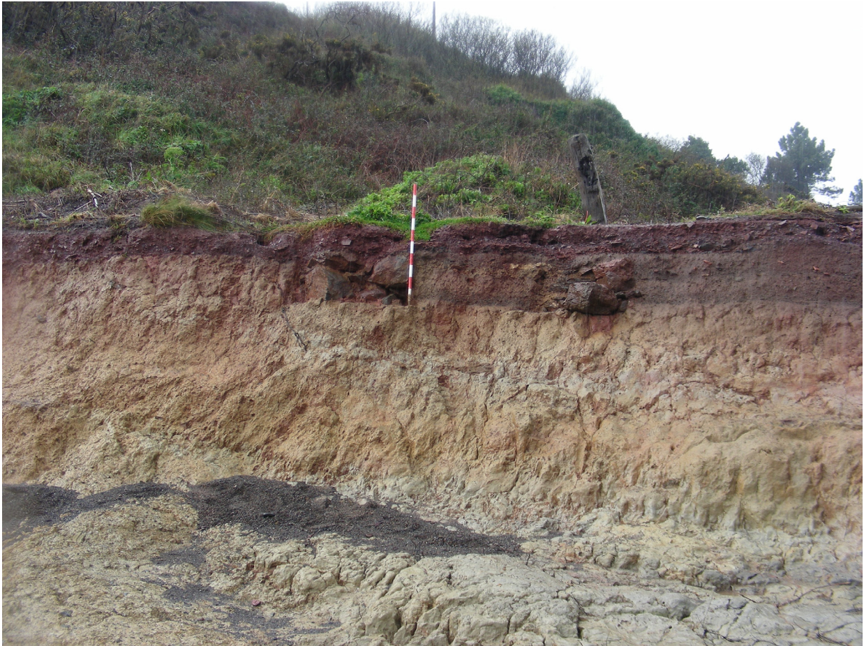
Figura 6.2.3. Proceso de erosión sobre terraza costera de la bahía de Llumeres. En el talud se observan restos de una construcción de época moderna. Aquí fue donde se hallaron los restos óseos en 2016. Foto N. Alonso Rodríguez.
