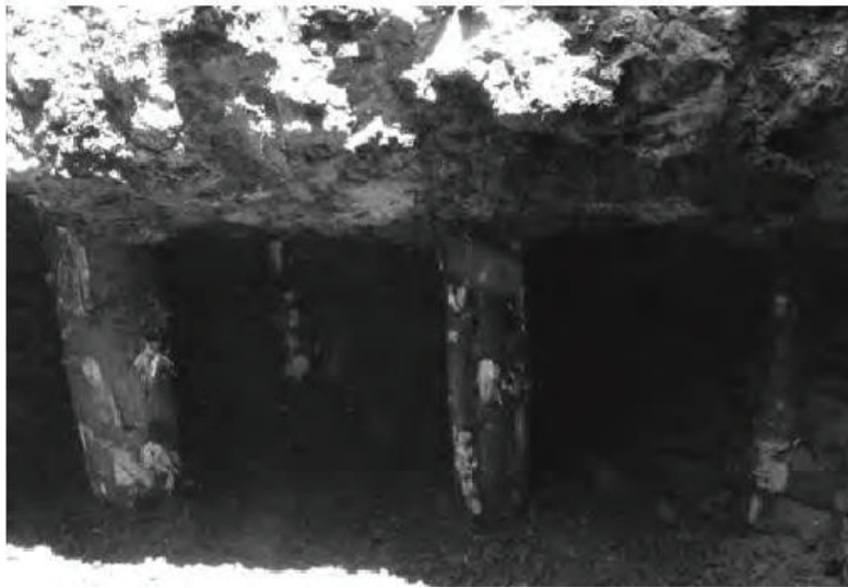
Figure 157: Détail du mur sud et du système de pilotis de l' Acequia de la Merced (Lugo Ramírez, 2007: 12)
