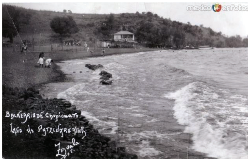
Figure 13: vagues sur les rives de la communauté de Chupicuaro, au nord du Lac de Pátzcuaro.
