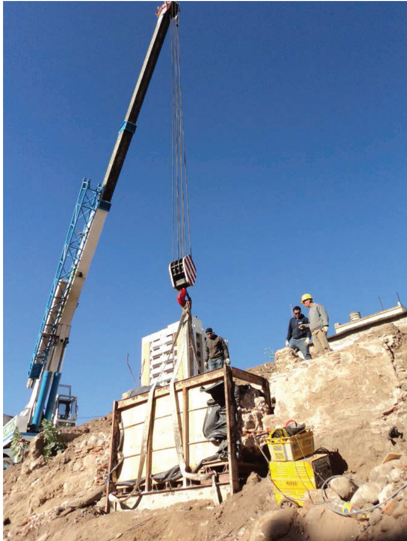
Figura 12.26. Preparación para la extracción del segundo sector del muro.
