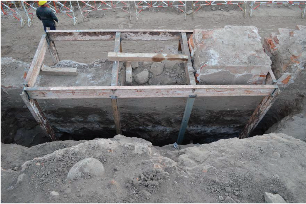
Figura 12.14. Vista superior y de la fachada sur del muro con todas sus partes soldadas.
