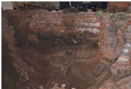
Figura 8.15. Detalle de perfil sur del Lote 11 en donde se ve la reutilización de piedra bola. Esta no se encontraba unida por ningún tipo de mortero. Nótese que los ladrillos se encuentran fragmentados y que no respetan el nivel horizontal.
