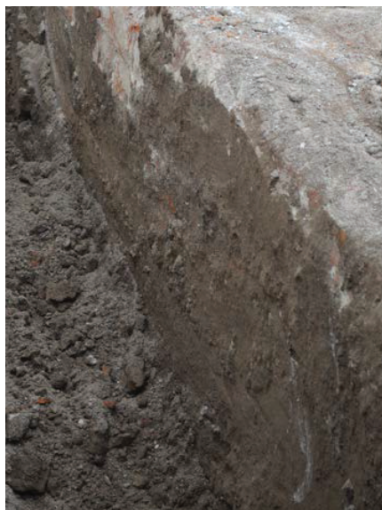
Figura 7.22. Revoque en el Sector B del muro. Se observa la adherencia de sedimentos en el mismo.
