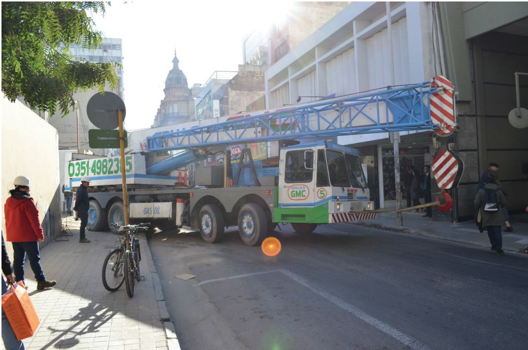
Figura 12.22. Grúa con capacidad de izado de 45 toneladas ingresando al predio del BANCOR.
