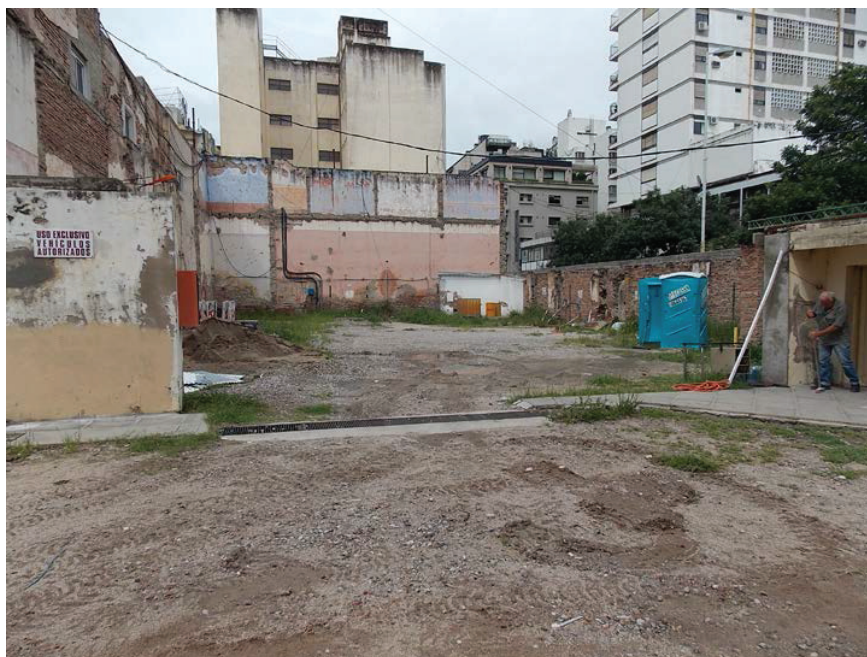
Figura 8.1. Lote 11 al momento de la visita de febrero de 2014. Se observa su uso como lugar de acopio de material y de baños químicos, junto a la casilla del guardia de seguridad.
