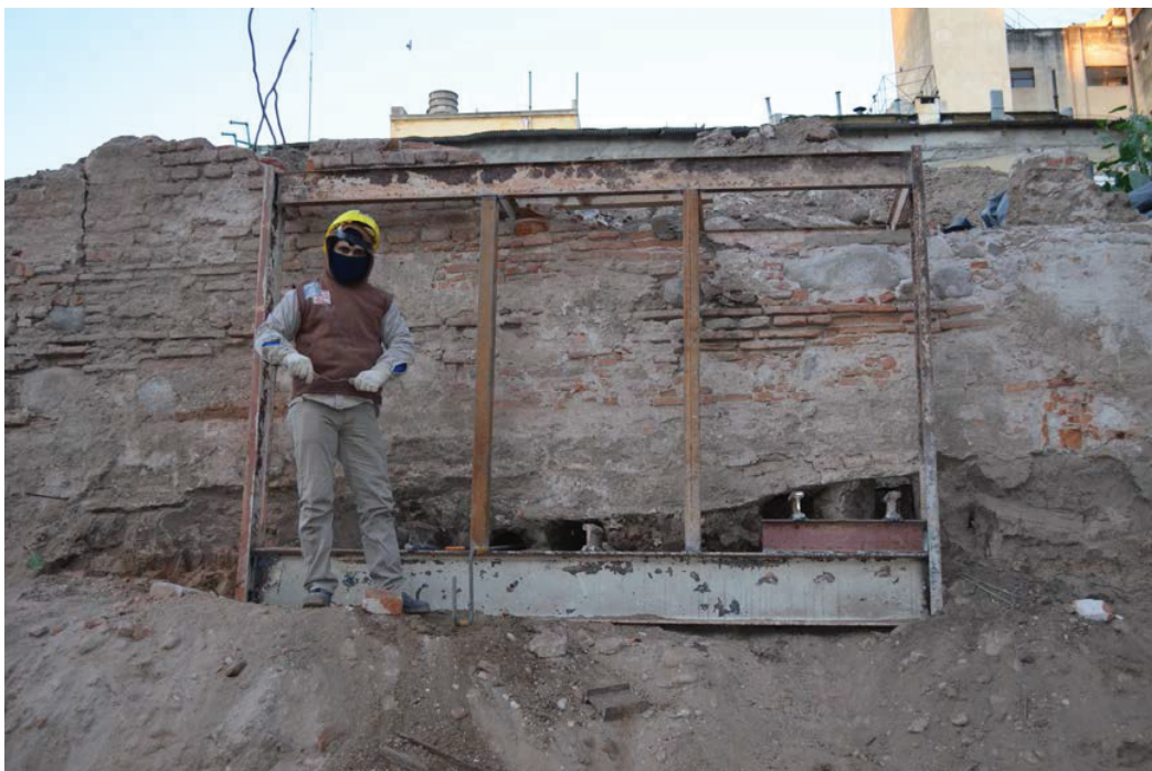
Figura 12.13. Adecuación del armazón a la forma basal del muro (nótese los suplementos colocados a la derecha de la estructura)
