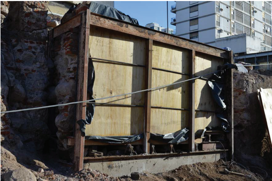
Figura 12.19. Sector del muro listo para su extracción.
