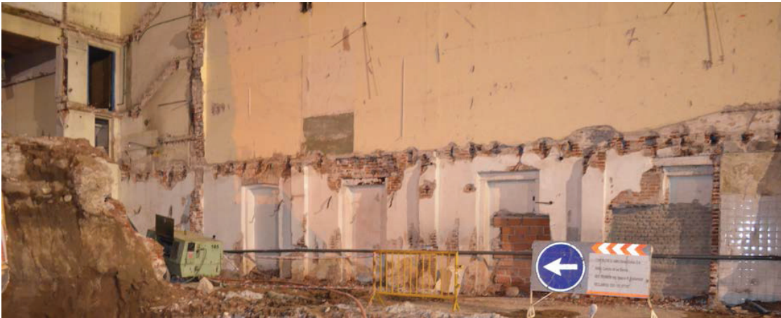
Figura 10.5. Lote 14 luego de la demolición. A la izquierda, a la altura del compresor de color verde, se encuentra el límite este del sótano que se desarrolla desde la línea municipal sobre calle Buenos Aires. Desde el centro y hacia la derecha se observan los vanos tapiados en distintos momentos y que comunican en varios puntos con el Lote 1.
