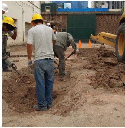
Figura 6.6. Remoción de la capa superior con maquinaria y obreros.
