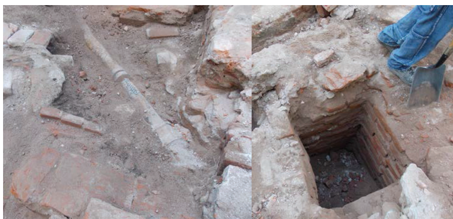
Figura 6.13. A la izquierda caño de hierro que atraviesa al muro antiguo de la cámara séptica, y a la derecha poso absorbente.
