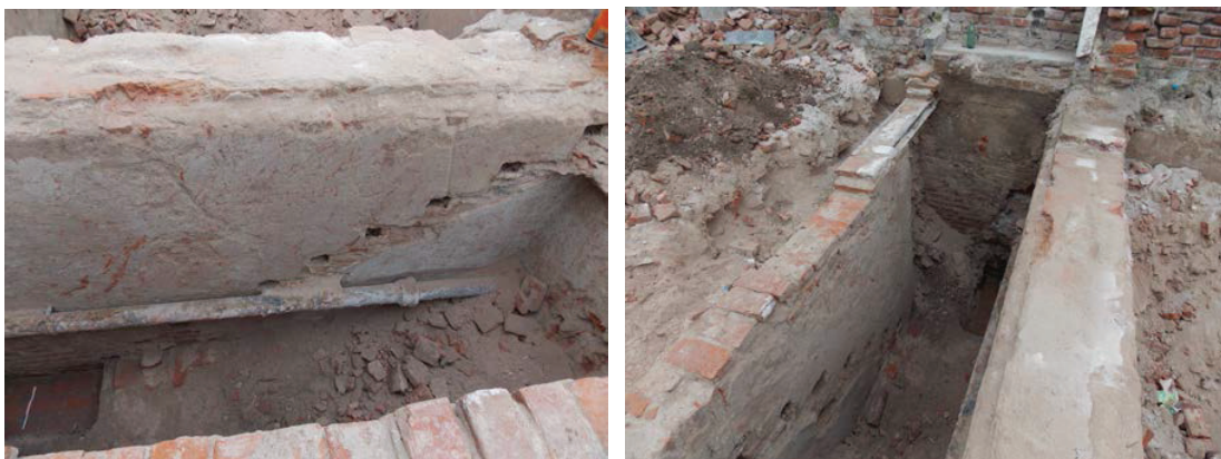
Figura 8.5. Entrada a sótano. Se observan a la izquierda los negativos donde calzaban los peldaños de la escalera. A la derecha se observa un dintel constituido por vigas de hierro y rellanado por fragmentos de tejas.
