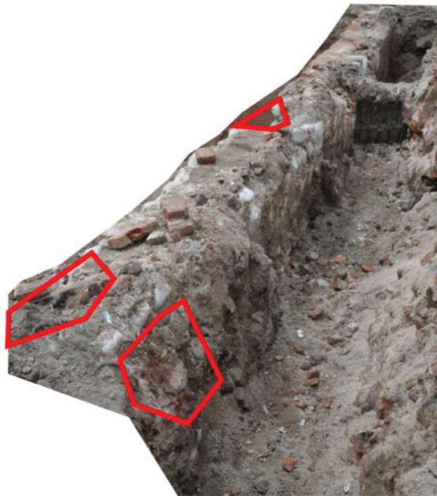
Figura 7.24. Intervenciones al muro con ingreso de material moderno (cemento, ladrillos industriales) y pérdida de material antiguo Sector B. Vista de Oeste a Este (desde Calle Buenos Aires hacia Ituzaingó)
