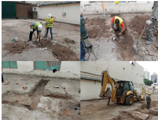
Figura 6.3. Comienzo de las actividades en el lote 3. En primera instancia se planteó la excavación con pico y pala, imagen de arriba a la izquierda, luego se utilizó martillo neumático para remover la primera capa y se continuo utilizando herramienta manual, foto de arriba a la derecha y abajo a la izquierda; para por último remover todo el estrato con maquinaria pesada, foto de abajo a la derecha
