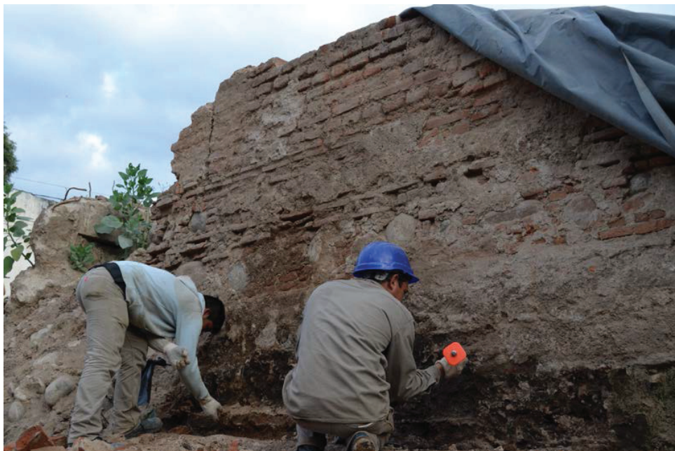
Figura 12.7. Limpieza mecánica del muro. Se puede observar sedimento negro que oficiaba de sostén de la parte inferior del muro.
