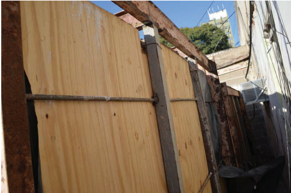
Figura 12.29. Disposición provisoria de ambos sectores del muro.
