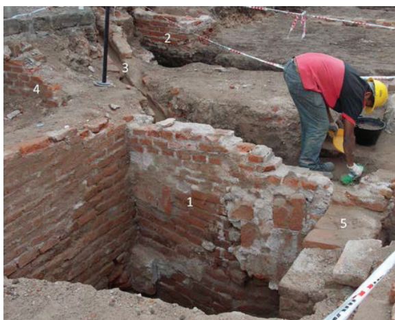
Figura 6.10. Cámara séptica moderna, la cual forma parte de un sistema de manejo de aguas negras. 1. Cámara séptica; 2, cámara de inspección; 3, albañal; 4 cámara séptica; 5; cámara.
