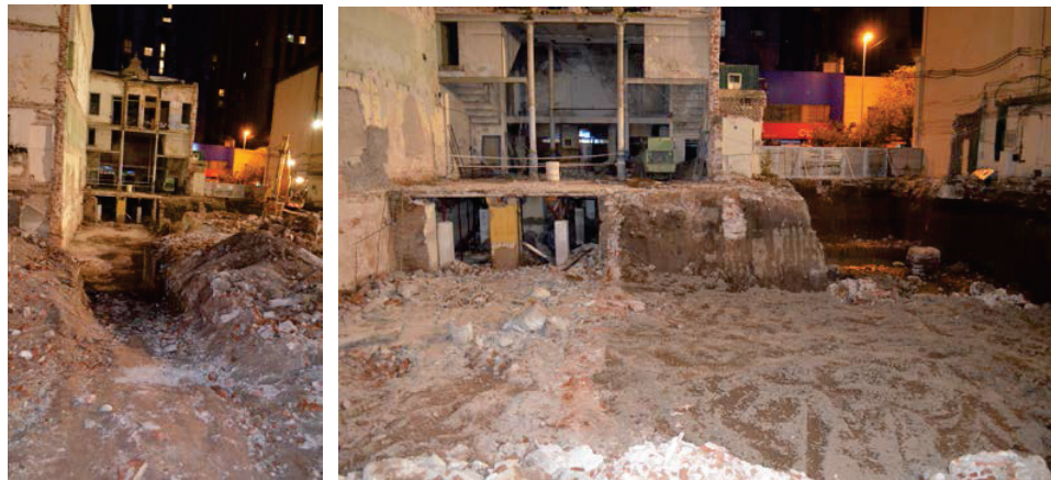
Figura 5.17. Vista general del Lote 2 durante el proceso de excavación con maquinaria.
