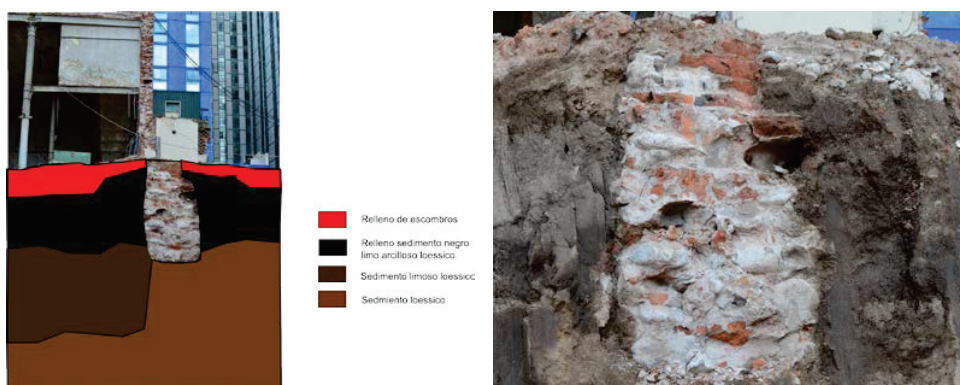
Figura 5.18: Izquierda: estratigrafía del Lote 2 en su porción este y del Lote 3 en su porción oeste. El límite lo identifica el cimiento de pared medianera. Derecha: Detalle del cimiento de la pared medianera (edificio de 1906). Se puede observar la reutilización en estas bases de piedra bola, pertenecientes muy probablemente a estructuras más antiguas del mismo.
