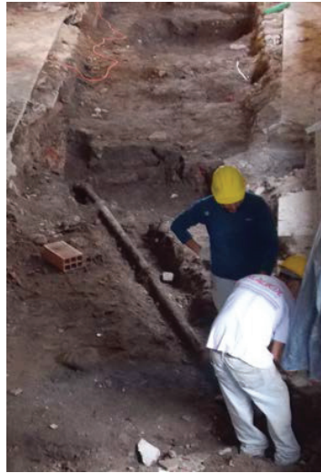
Figura 5.9. Detalle de los caños de hierro y sus bases (UEs 4, 5 14, 15 y 17).
