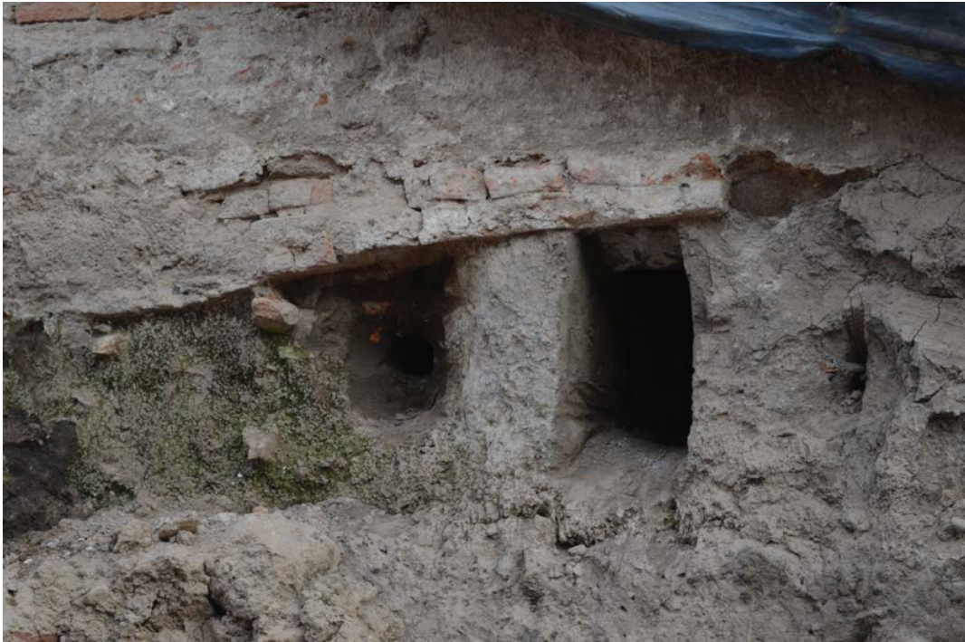
Figura 12.8. Detalle de algunas de las excavaciones por donde se colocarían los perfiles IPN12.
