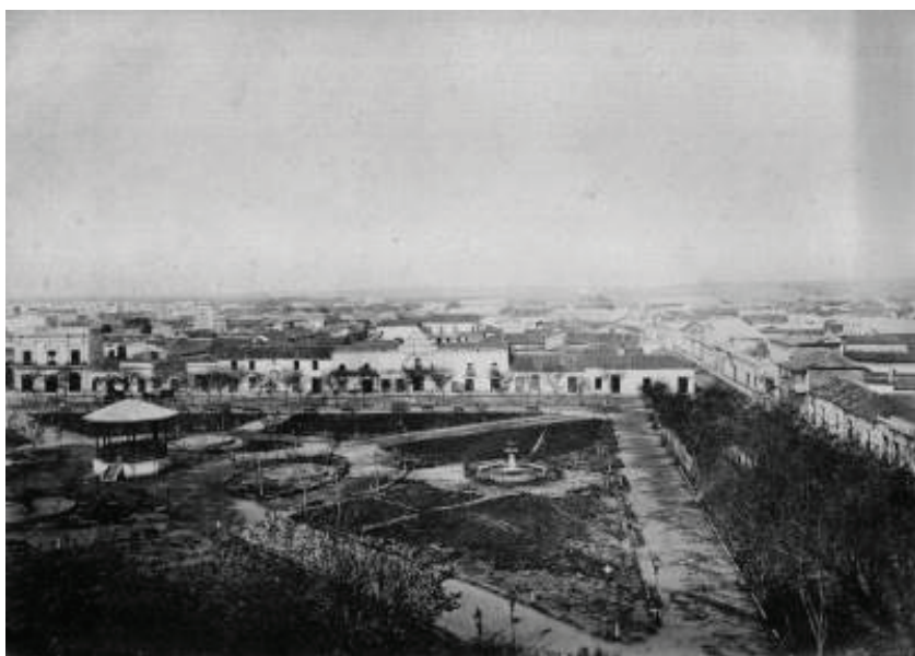
Figura 3.18. Una de las primeras imágenes de la ciudad de Córdoba. Hacia la derecha, dónde se ubica nuestra área de interés se observa la manzana con típicas construcciones coloniales. Gentileza del Arq. Jorge Bettolli (Imagen digitalizada por el Museo de la Ciudad, Municipalidad de Córdoba).
