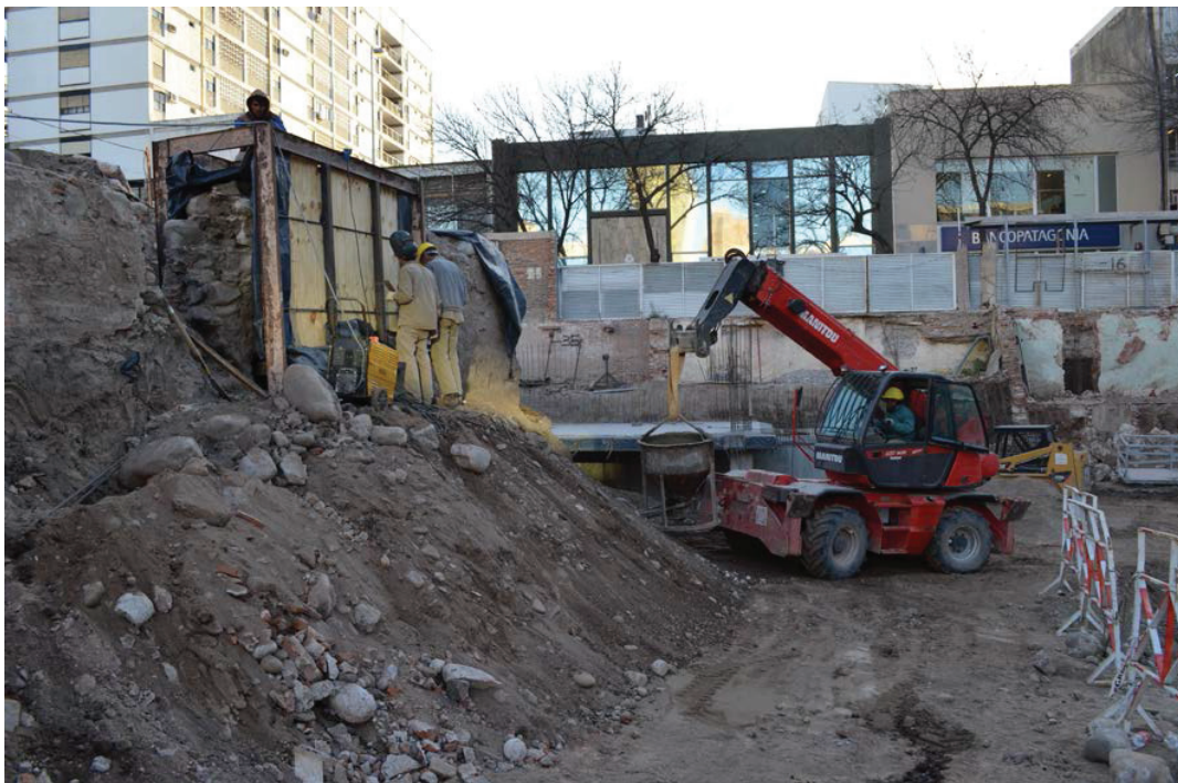
Figura 12.21. Finalizando el confinamiento de un sector del muro.
