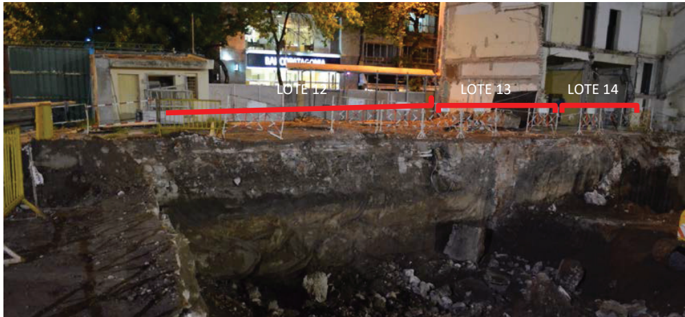
Figura 10.7. Perfil N-S Lotes 12, 13 y 14 (de izquierda a derecha). Pueden observarse la superposición de los distintos estratos esquematizados en el Figura 10.6. En el fondo de la excavación pueden observarse restos de material de la demolición de los edificios de 1936 y 1905, como por ejemplo la base de columna con forma de cubo ubicada en el centro y recostada sobre el perfil.
