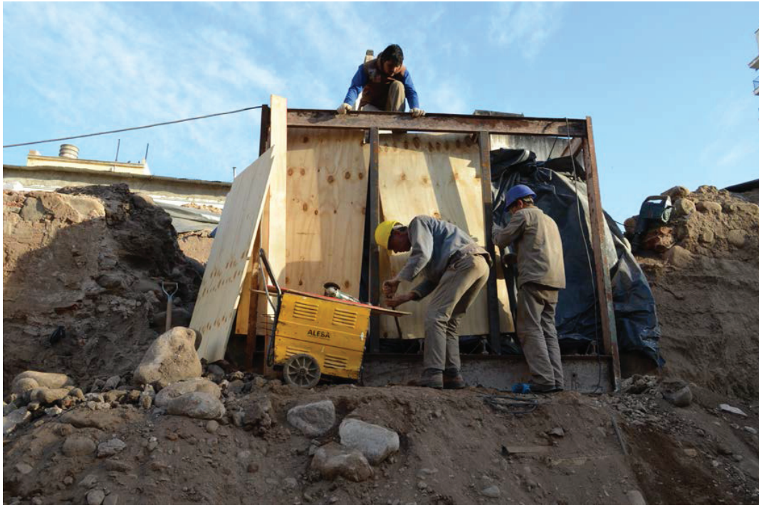
Figura 12.20. Preparación de las paredes de fenólico con el fin de contener arena.
