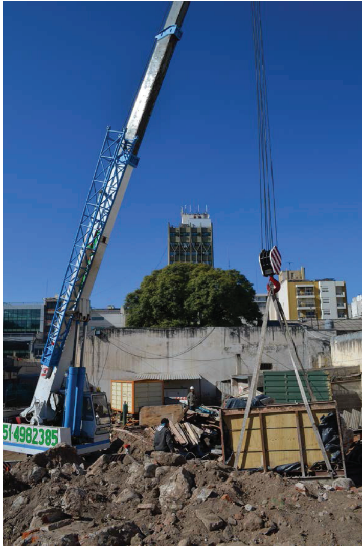
Figura 12.25. Primer sector del muro extraído y rumbo a su posición provisoria.
