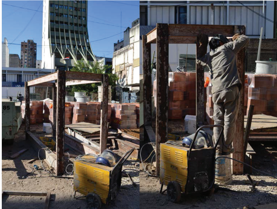
Figura 12.6. Estructura de sostén del muro en su etapa de construcción.
