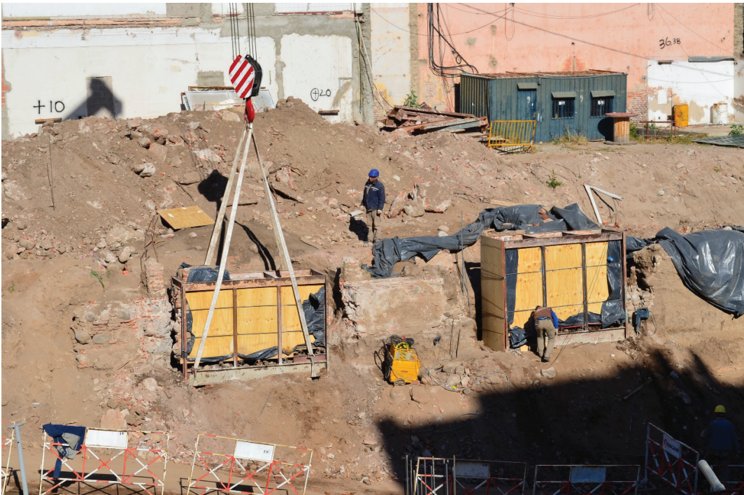
Figura 12.23. Armazón completo listo para ser izado.
