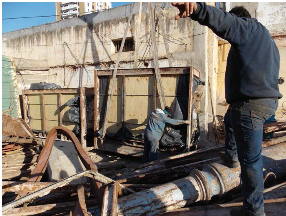
Figura 12.28. Segundo sector del muro aproximándose a su posición provisoria, junto al sector de muro retirado previamente.
