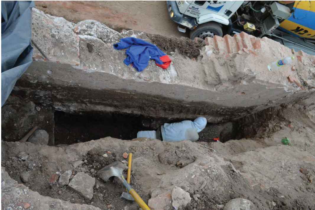
Figura 12.10. Acondicionamiento de la pared correspondiente al Lote 9. A la izquierda se observa la zapata de hormigón en la parte inferior de la trinchera.
