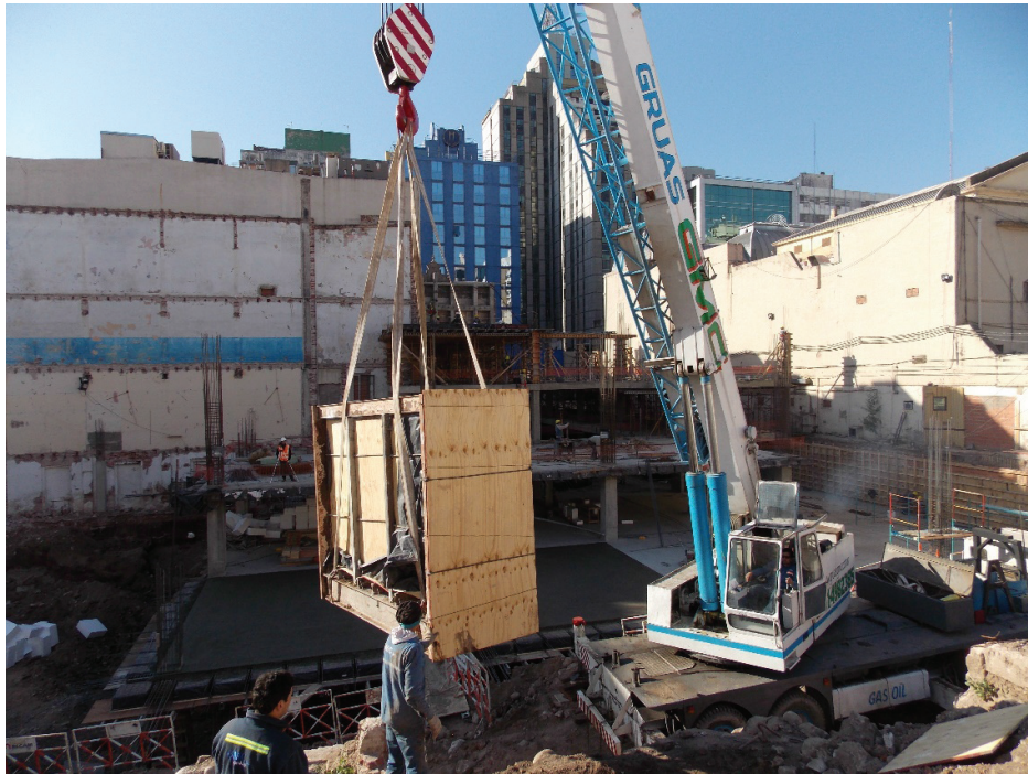
Figura 12.27. Extracción del segundo sector del muro.
