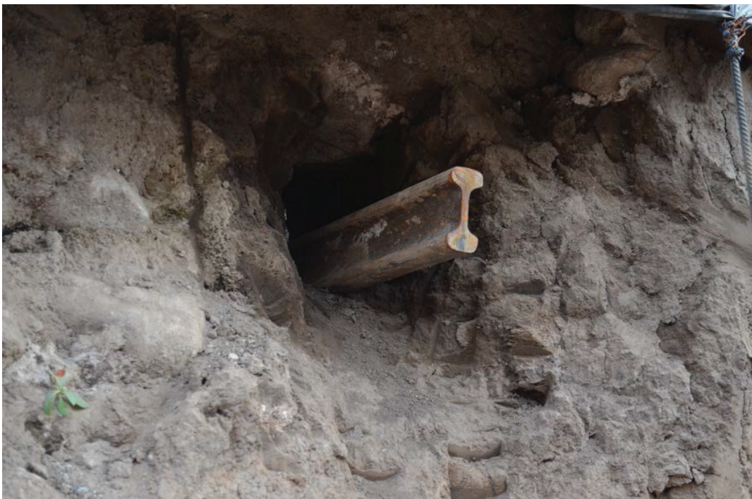
Figura 12.9. Perfil IPN 12 presentado por debajo del muro.
