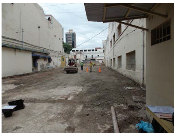
Figura 6.1. Lote tres luego se ser removido el piso de baldosas cementicias.
