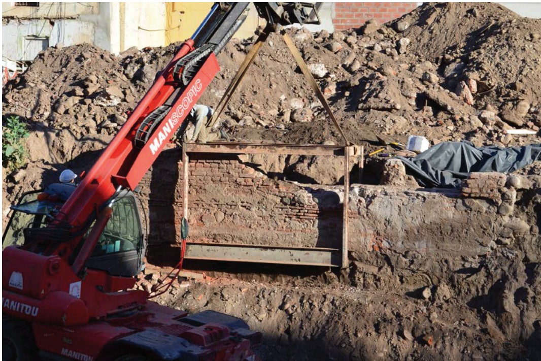
Figura 12.12. Presentación del armazón en un sector del muro.
