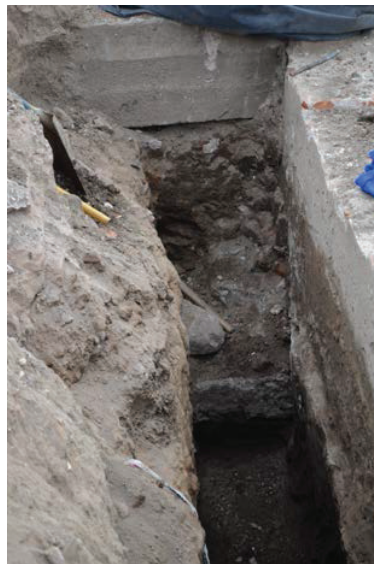
Figura 12.11. Detalle de la zapata de hormigón que presenta en su fábrica alguna piedra bola.
