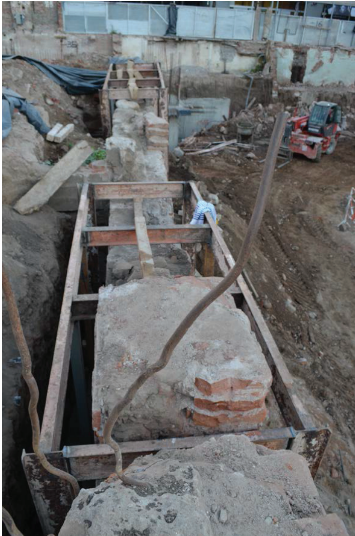
Figura 12.16. Vista en dirección este-oeste de los armazones colocados sobre el muro.
