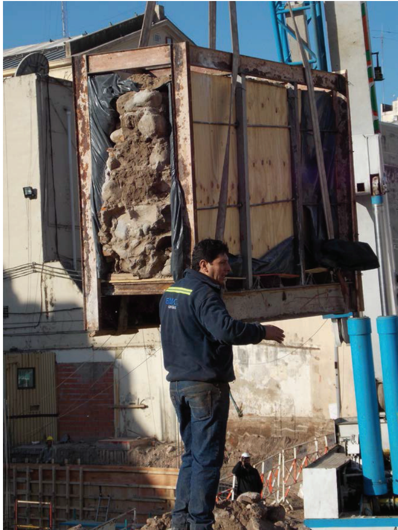
Figura 12.24. Izado del primer sector del muro Puede observarse su integridad estructural.
