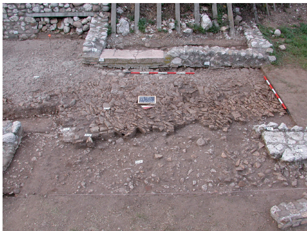
FIG. 13. PAVIMENTAZIONI IN COCCIOPESTO DELL'ESEDRA 26 E DEL PORTICO, E SOTTOPAVIMENTAZIONE IN LATERIZI. IN FONDO LA SOGLIA IN MARMO ROSA DI VERONA (FOTO DELL'AUTORE).
