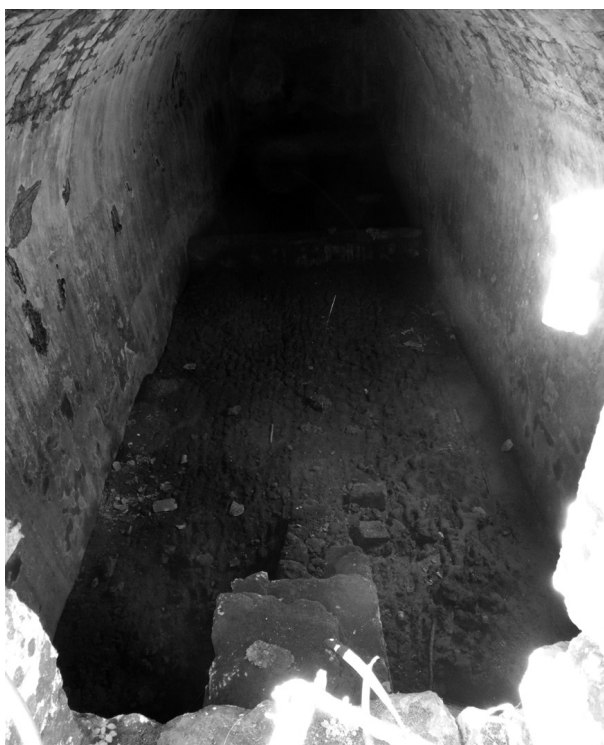
FIG. 3. ANTICA CISTERNA IN LOCALITÀ CISTERNAZZA DI SOPRA.
