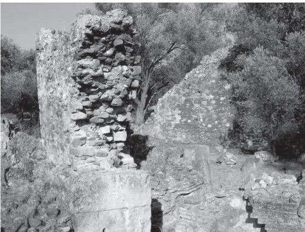
Figura 152. Muro occidentale del castello di distribuzione adattato in epoca protobizantina a sostegno per le arcate del ramo C dell'acquedotto.
