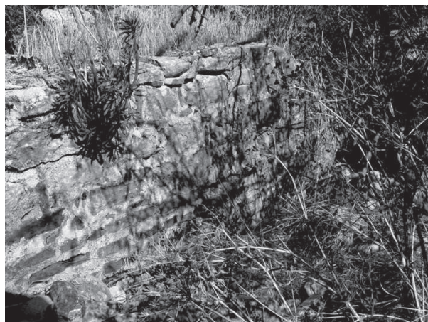
Figura 127. Dettaglio della muratura con le fasce di laterizi.
