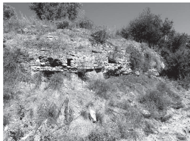
Figura 100. Tratto di acquedotto LT 14 a N dei blocchi crollati; è ben visibile una delle aperture per il drenaggio delle infiltrazioni di acqua.
