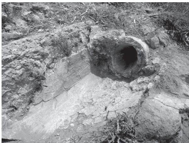
Figura 114. Tubo fittile per la canalizzazione delle acque del troppo pieno della camera di raccolta in un tratto di speco fuori uso (di una delle fasi precedenti).
