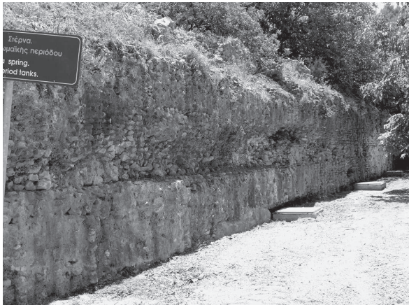
Figura 19. La cisterna dell'opera di presa a Nord di Zarós (cat. nr. 1).
