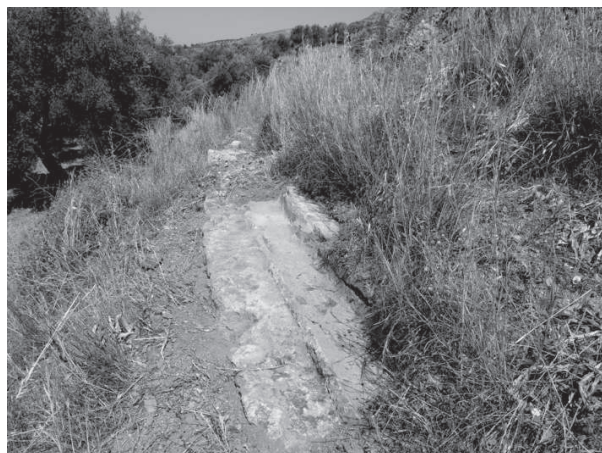
Figura 124. Tratto dell'acquedotto con il canale in evidenza.
