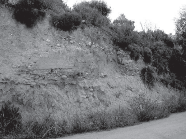
Figura 101. Traccia del rivestimento interno dello speco, a sinistra, e della muratura, a destra.
