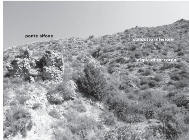
Figura 108. I resti della spalla occidentale del ponte visti da valle. Sulla destra un tratto del condotto inferiore che entrava nel dispositivo del sifone inverso; la briglia di raccordo originaria non si è conservata, mentre i pochi resti esistenti sono riconducibili all'ultimo restauro; in alto si intravede il condotto superiore dell'acquedotto.
