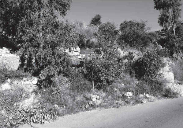
Figura 103. La struttura del tratto di acquedotto LT 11 scivolata verso il ciglio della strada.
