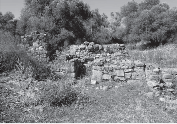
Figura 137. Punto di attingimento diretto dallo speco dell'acquedotto sul prospetto settentrionale del ramo H.
