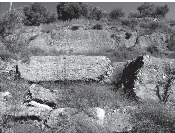
Figura 99. Tratto di acquedotto LT 14; in alto la parete brecciosa da cui si sono staccati i blocchi di conglomerato della muratura dell'acquedotto, in primo piano.
