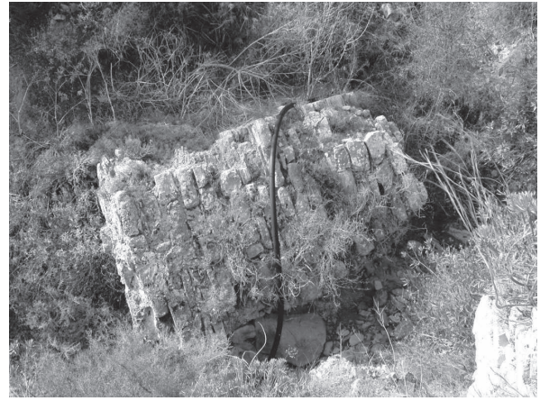
Figura 41. Resti dell'acquedotto franati nella gola del Mitropolianos.
