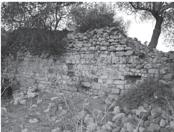
Figura 43. Un tratto di acquedotto sostenuto da un muro pieno (ramo A).
