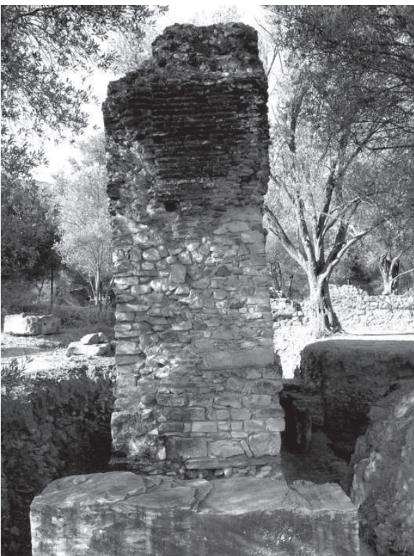
Figura 152. Muro occidentale del castello di distribuzione adattato in epoca protobizantina a sostegno per le arcate del ramo C dell'acquedotto.
