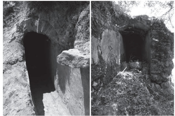
Figura 23. Coperture a volta e a capanna in due diversi tratti del canale di adduzione (cat. nrr. 4 e 5).
