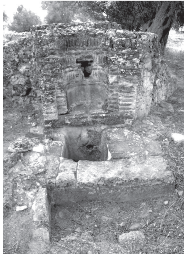
Figura 57. Uno dei punti di attingimento della cisterna/fontana nr. 88: in basso il pozzetto-abbeveratoio.
