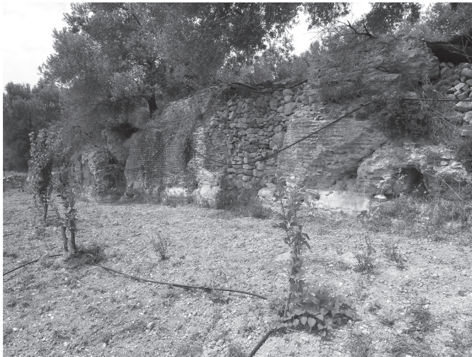
Figura 24. Muratura a cortina laterizia del canale di adduzione (cat. nr. 8).
