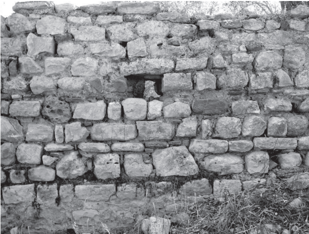
Figura 38. La tecnica costruttiva a bocchetti parallelepipedi in una delle cisterne-fontane dell'area urbana.
