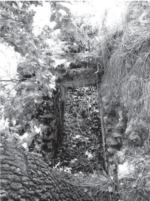
Figura 83. Tratto di acquedotto: particolare dello speco con copertura piana.
