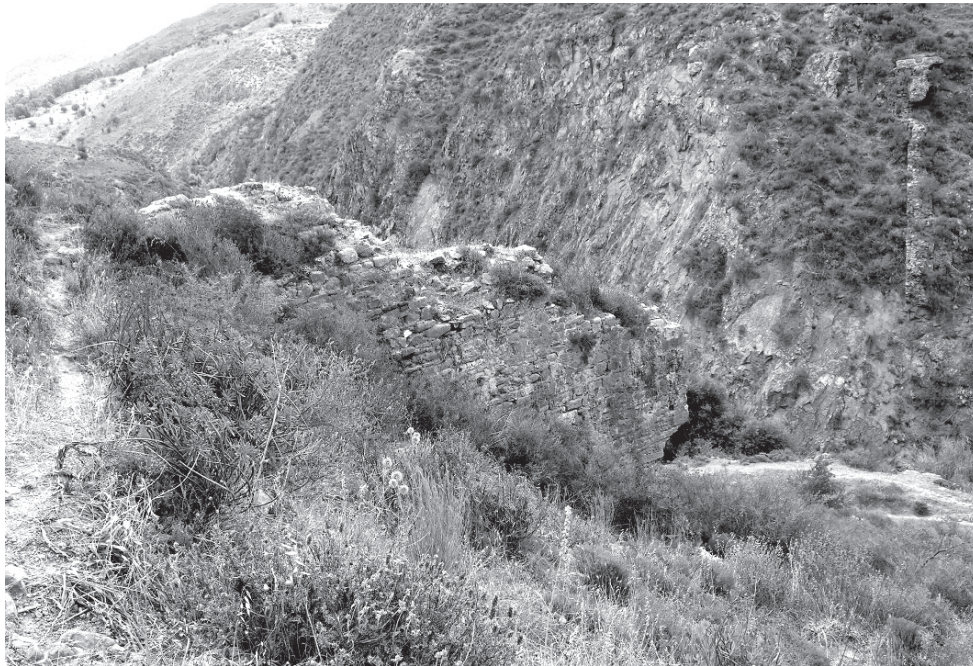
Figura 27. I resti del ponte-sifone sulle due pareti della gola, da Ovest (cat. nr. 18).
