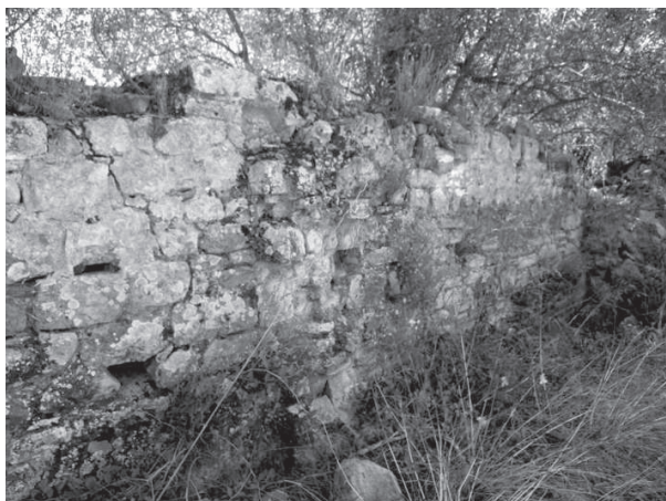
Figura 126. Uno dei setti perpendicolari al muro principale dell'acquedotto.
