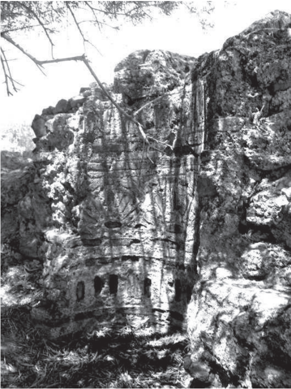
Figura 172. Dettaglio delle decorazioni in laterizi che inquadrano la nicchia con il punto di attingimento sul prospetto orientale della cisterna/fontana.
