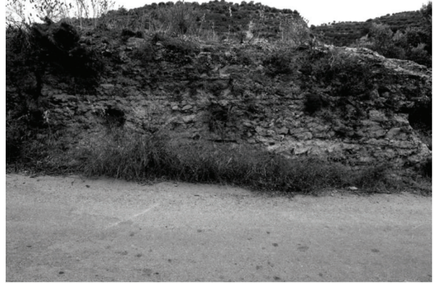
Figura 87. Dettaglio della tecnica edilizia.
