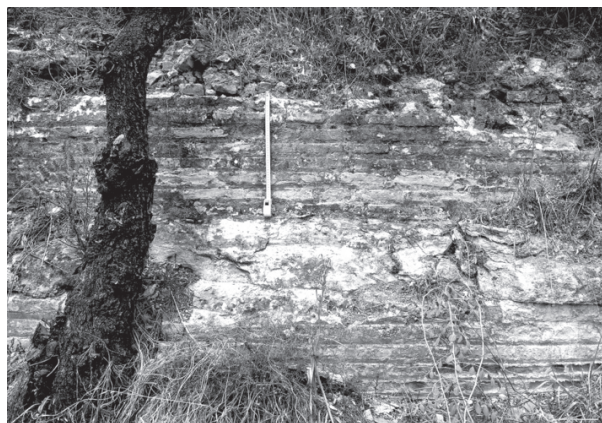
Figura 90. Dettaglio della tecnica edilizia.
