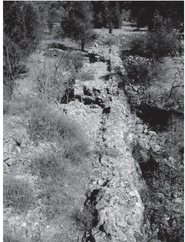
Figura 180. Dettaglio del condotto di adduzione che corre lungo il lato orientale della struttura.
