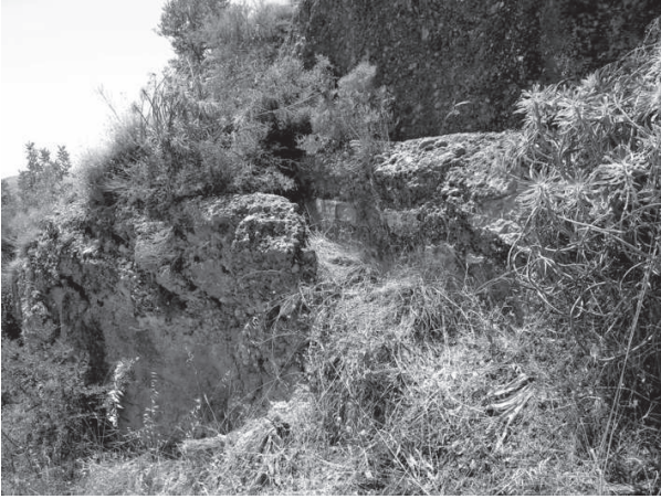
Figura 81. Tratto di acquedotto.
