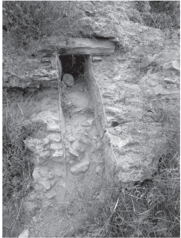
Figura 112. La caditoia pertinente la fase romana del ponte, poi obliterata.
