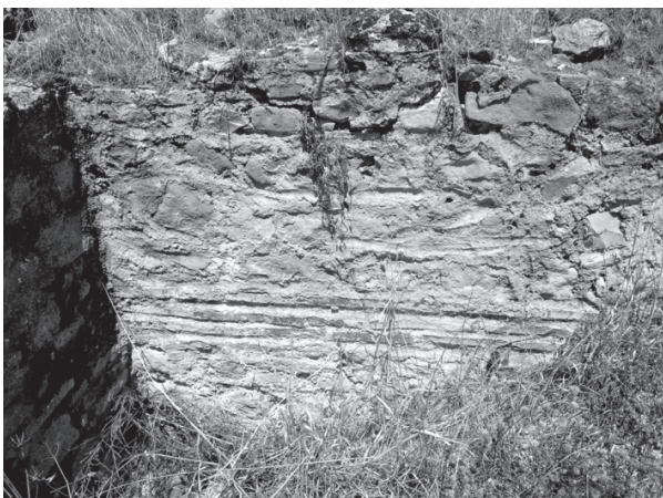
Figura 174. Particolare della tecnica edilizia del muro occidentale.
