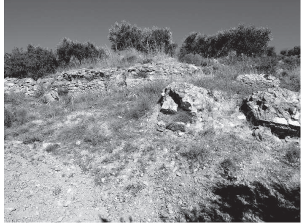
Figura 102. Tratto di acquedotto LT 12 a N di LT 11.
