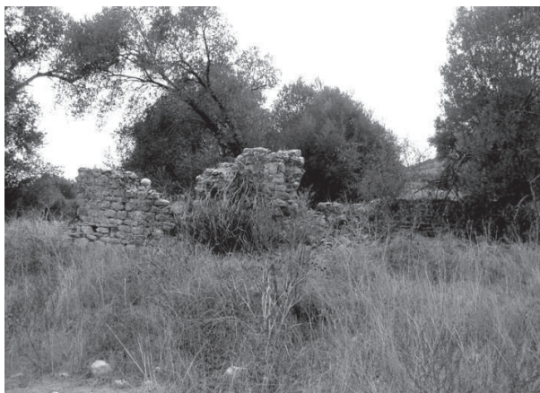
Figura 128. Diramazione dell'acquedotto verso la fontana nr. 69.
