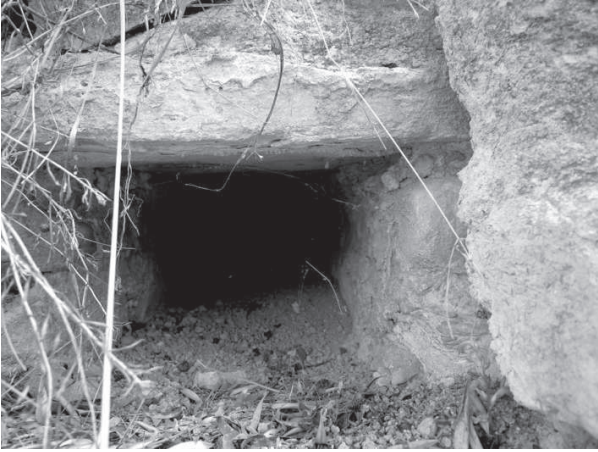
Figura 91. Dettaglio di una delle aperture per il drenaggio delle acque di caduta.
