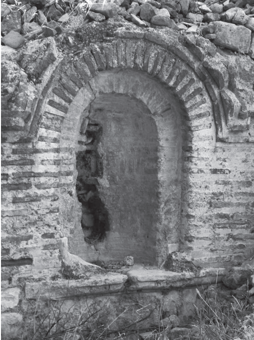
Figura 54. Dettaglio di uno dei punti di attingimento della cisterna/fontana nr. 78: si nota l'asportazione del rubinetto di controllo del flusso.
