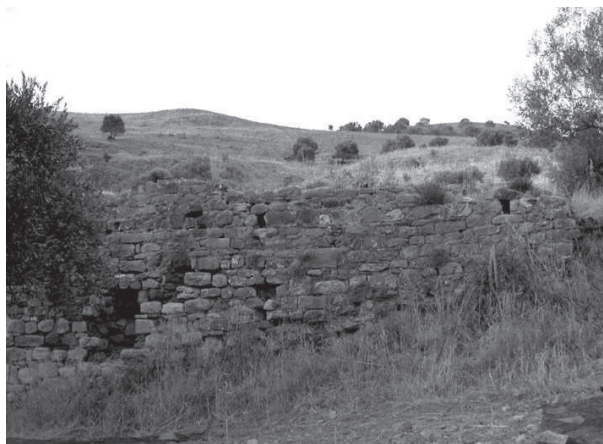
Figura 123. Particolare della tecnica edilizia dell'acquedotto.
