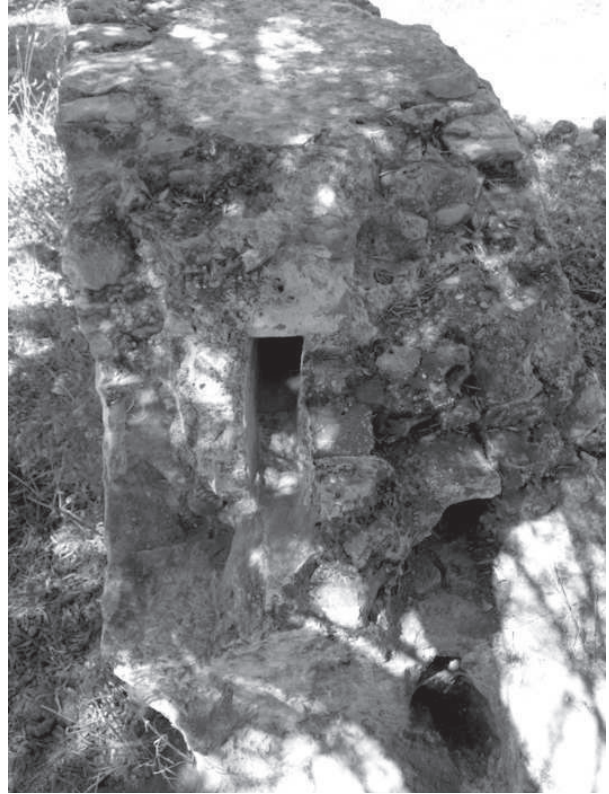
Figura 144. Dettaglio del canale sul muro perimetrale E.
