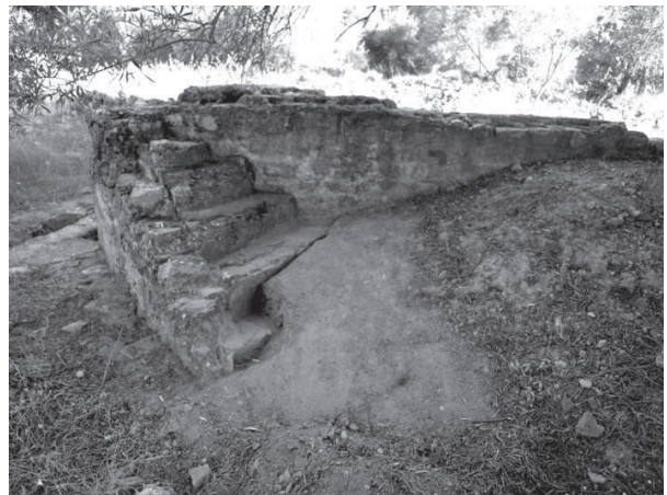
Figura 171. La scala addossata al prospetto orientale della vasca.
