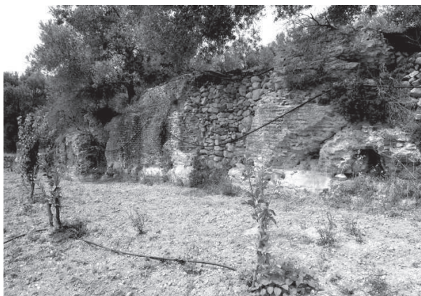
Figura 89. Prosecuzione dello stesso tratto verso N.
