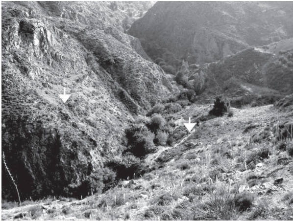
Figura 107. Vista da N delle due spalle del ponte sifone (indicate dalle frecce) nella gola del Mitropolianòs; in alto a destra le pendici della collina dell'acropoli.
