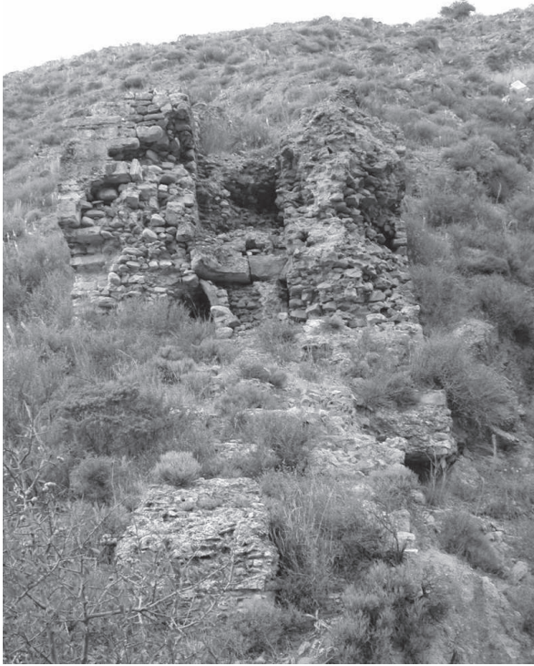
Figura 40. La spalla occidentale del ponte-sifone. Sulla sinistra dell'immagine si coglie la sovrapposizione stratigrafica della rifoderatura di epoca protobizantina sul nucleo cementizio preesistente.
