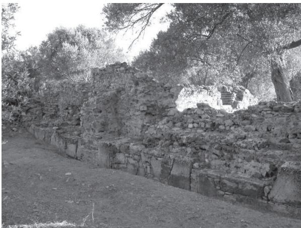
Figura 164. Tratto di acquedotto che alimentava la cisterne/fontana.
