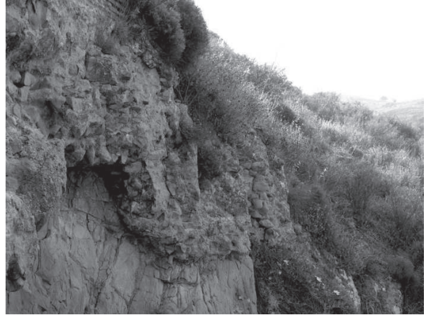
Figura 118. La struttura dell'acquedotto costruita sulla parete rocciosa verticalizzata.
