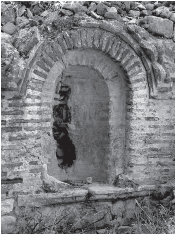
Figura 150. Dettaglio della nicchia in laterizi che inquadrava il punto di attingimento, con le tracce dell'asportazione del rubinetto metallico.
