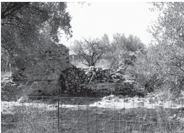
Figura 181. Prospetto settentrionale della cisterna/fontana.
