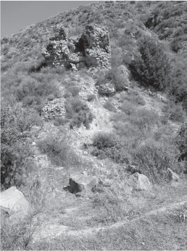
Figura 111. Vista della struttura del ponte dalla gola; sotto sono visibili i resti di un probabile pilone di prima fase che poteva sostenere il ponte in una posizione più avanzata rispetto al letto del fiume.
