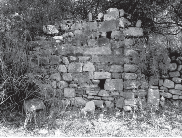
Figura 136. Dettaglio della tecnica edilizia.
