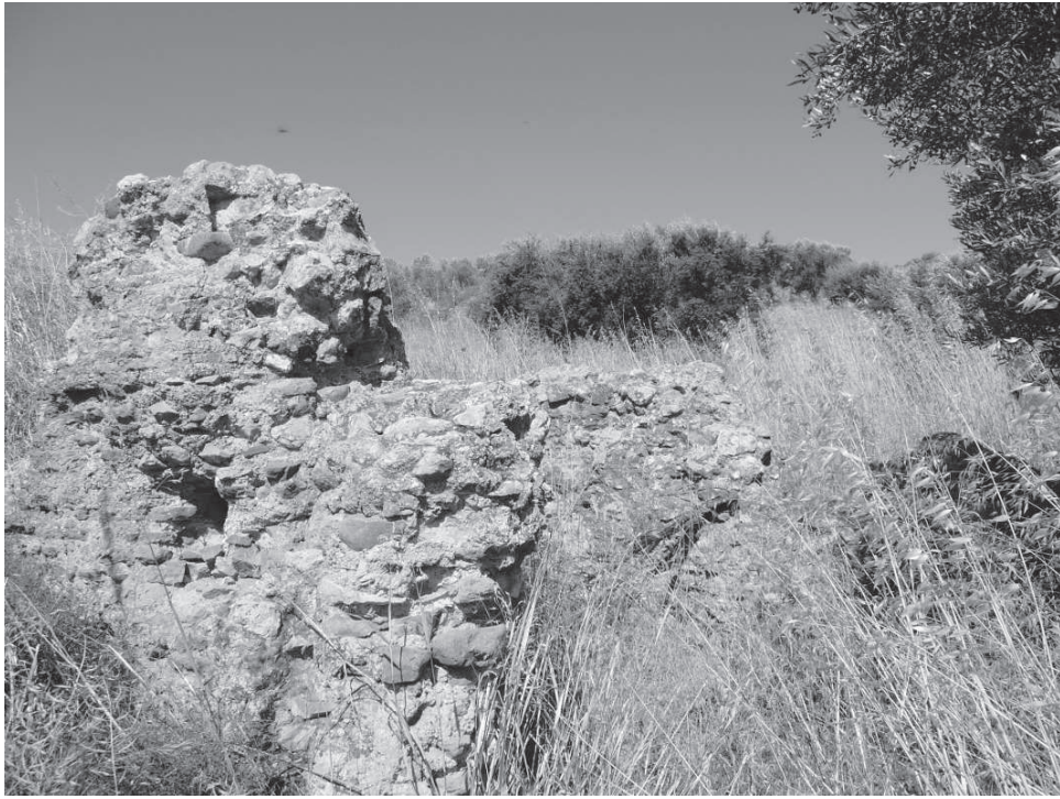
Figura 11. Ruederi di strutture connesse con la gestione delle acque nel territorio di Gérgeri, a valle del villaggio di Apomarmà.
