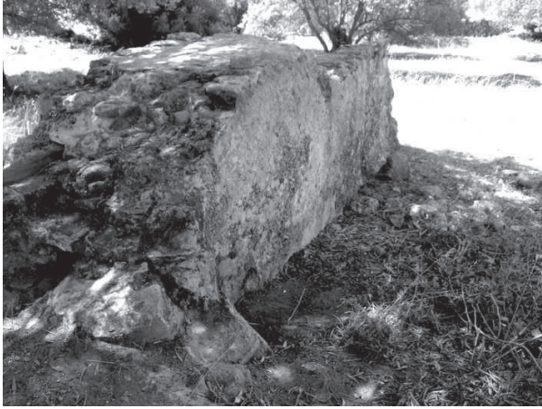
Figura 143. Angolo interno della struttura con il rivestimento in malta idraulica.
