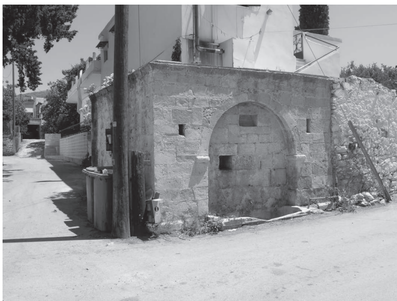
Figura 53. Cisterna di epoca moderna nel villaggio di Agioi Dekà.
