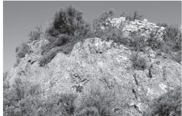
Figura 105. Tratto di acquedotto curvo in corrispondenza di uno sperone roccioso.
