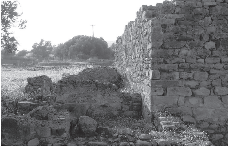
Figura 69. Vasca e apprestamenti sul lato Sud della cisterna/fontana nr. 84.
