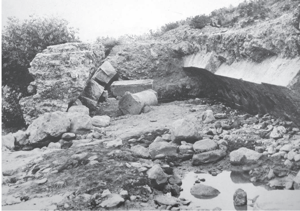
Figura 15. I resti delle volte di copertura del Mitropolianòs in una fotografia dell'Archivio SAIA (da Di Vita 2010, p. 273, fig. 397).
