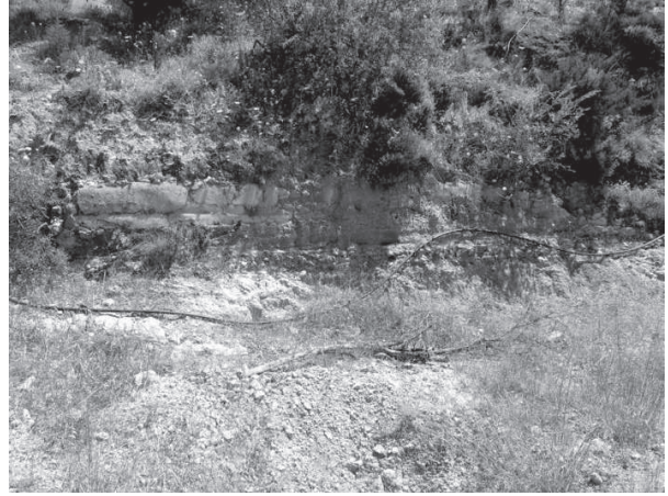
Figura 82. Tratto di acquedotto.
