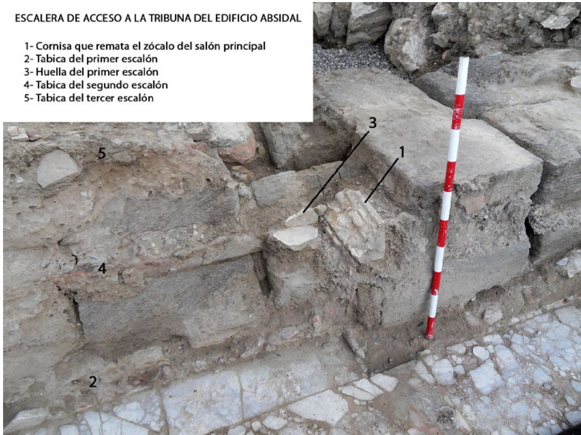
DETALLE DE LA ESCALERA DE ACCESO A LA TRIBUNA DEL EDIFICIO ABSIDAL.
