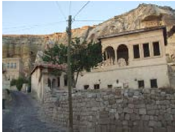
FIGURE 7. SUCUOĞLU KONAĞI, ÜRGÜP, NEVŞEHİR
