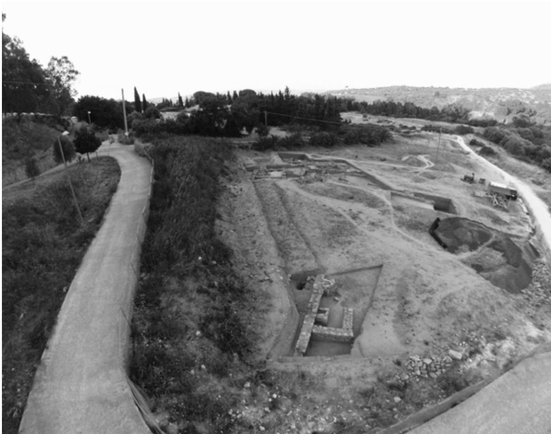
Fig. 1 Veduta generale dell'area del cantiere durante le indagini
